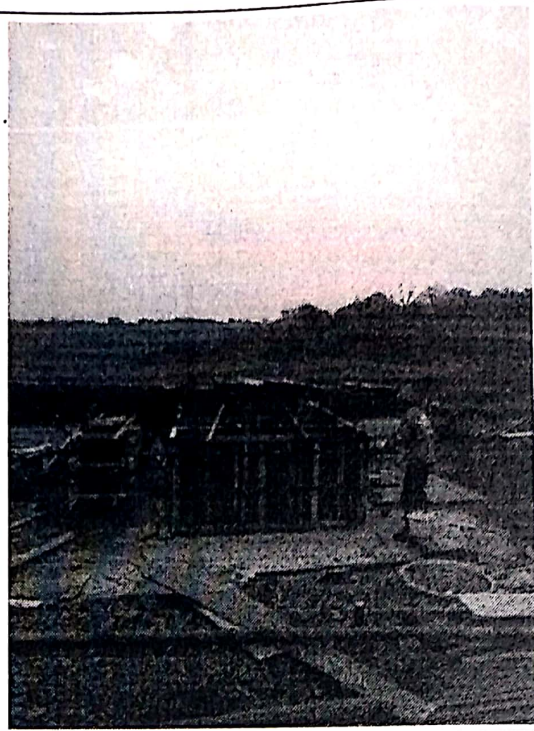
SVG 变压器基础支模
