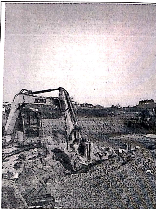
生活仓基础土方开挖
