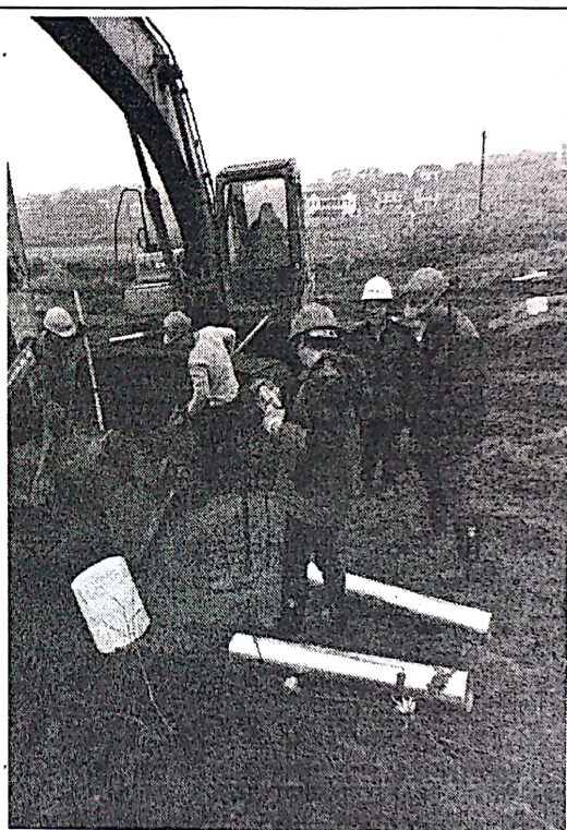
4 区灌注桩混凝土浇筑旁站
