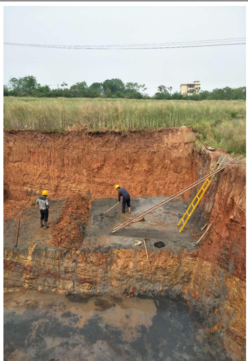
5#塔基基础垫层铺设
