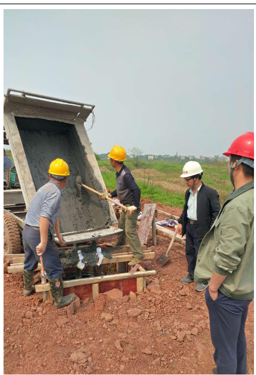
监理人员旁站 8#塔基基础浇筑
