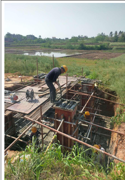
3#塔基基础浇筑振捣
