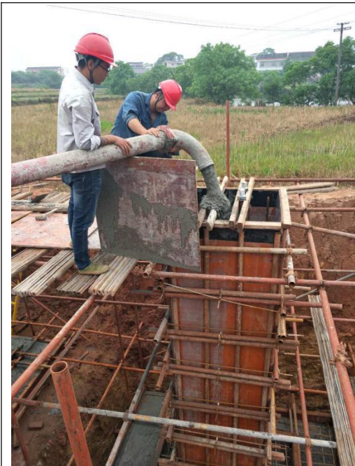
5#塔基基础混凝土浇筑施工
