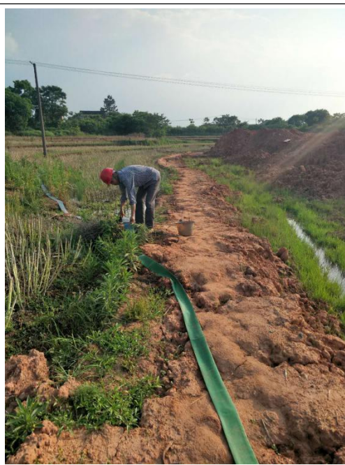
5#塔基基础抽排水
