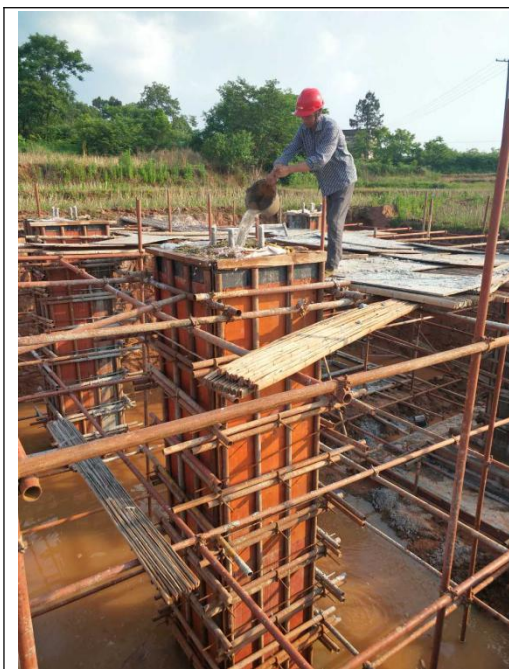
5#塔基基础混凝土保养
