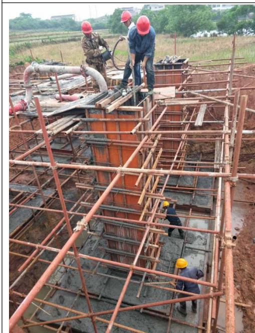
5#塔基基础混凝土浇筑施工
