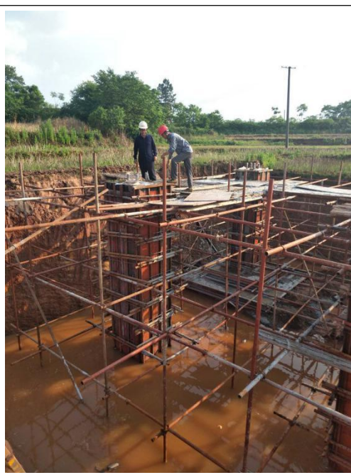
监理人员巡视检查
