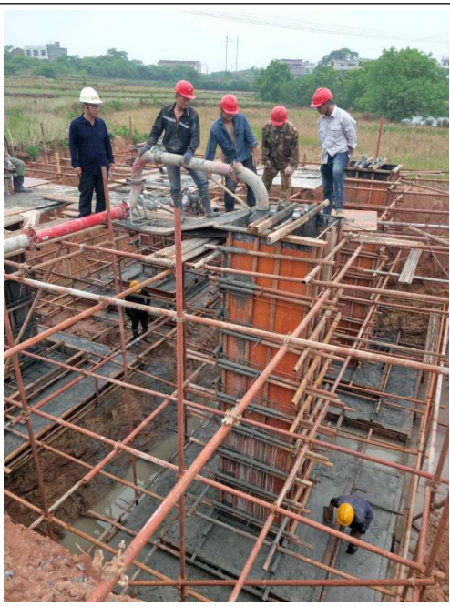
5#塔基基础混凝土浇筑施工旁站
