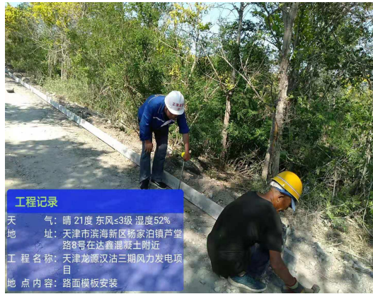
检查道路砼浇筑厚度
