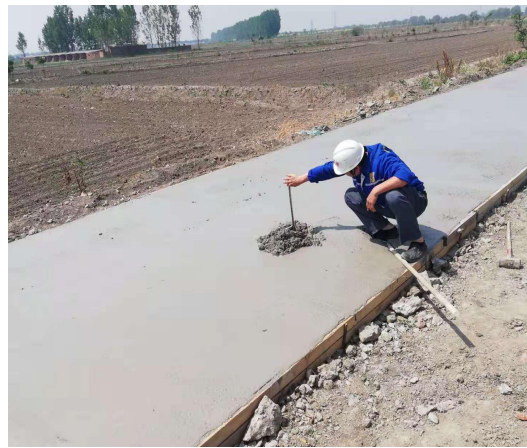
检查道路砼浇筑厚度
