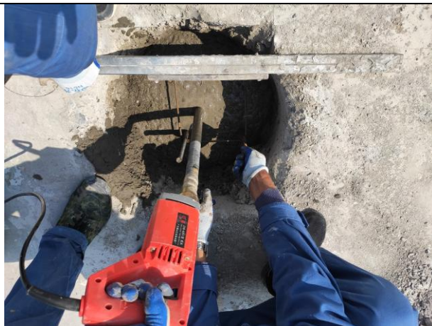
钢结构基础孔洞砼浇筑振捣
