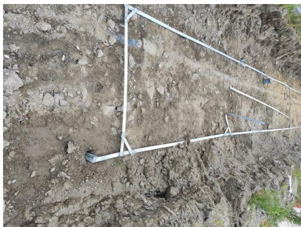
设备基础开挖接地预埋
