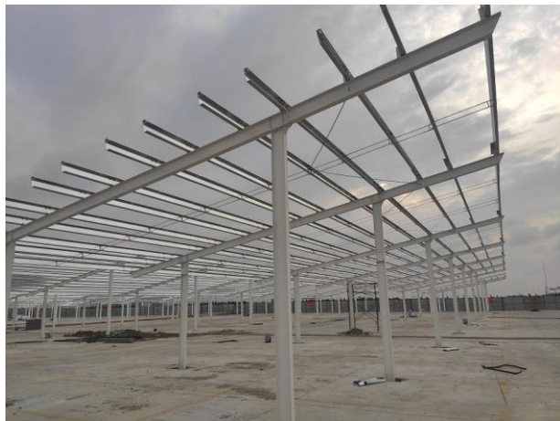
钢结构 C 型钢安装
