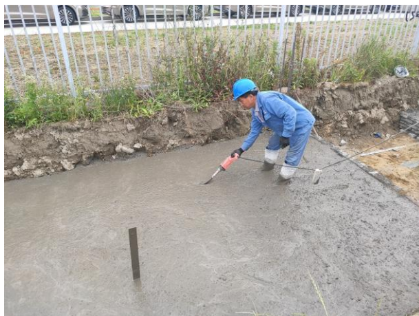
设备承台砼浇筑振捣
