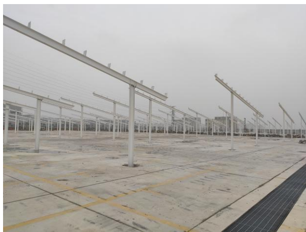
钢结构立柱及斜梁安装
