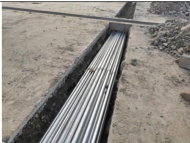
电缆镀锌钢管敷设
