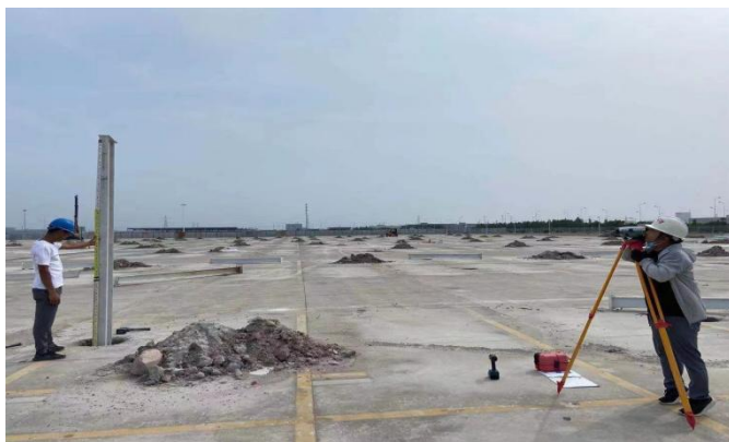
8、检查组件螺栓紧固情况
