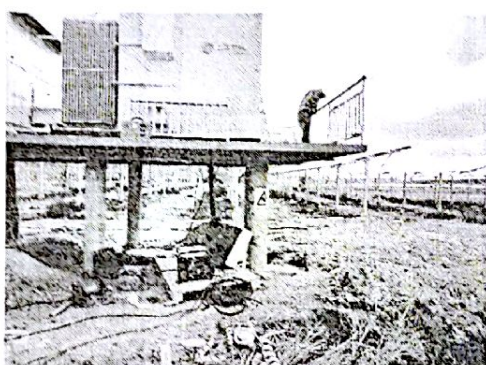
5、箱变安装（已完成 17台共100%）
