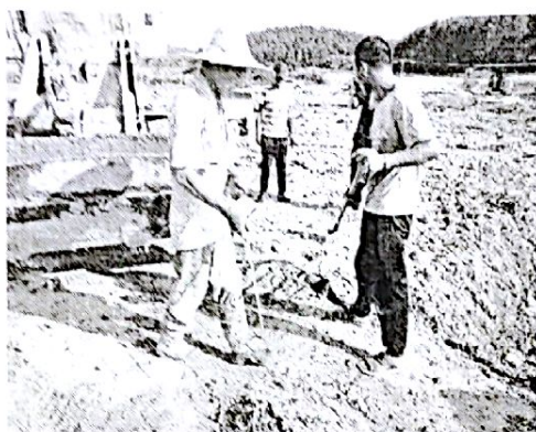
4、灌注桩浇筑（已完 成58mw 约96.7%）
