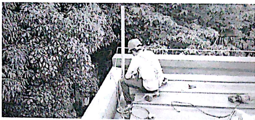
兄弟标准件 5#屋面夹具安装完成
