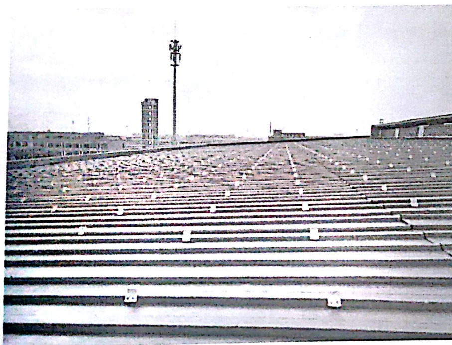
大宁施工点夹具安装
