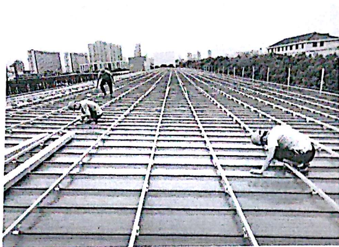
大宁施工点夹具安装
