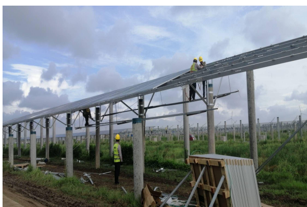
光伏组件安装
