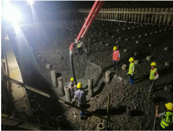
升压站配电楼基 础垫层浇筑
