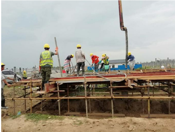
箱变基础浇筑
