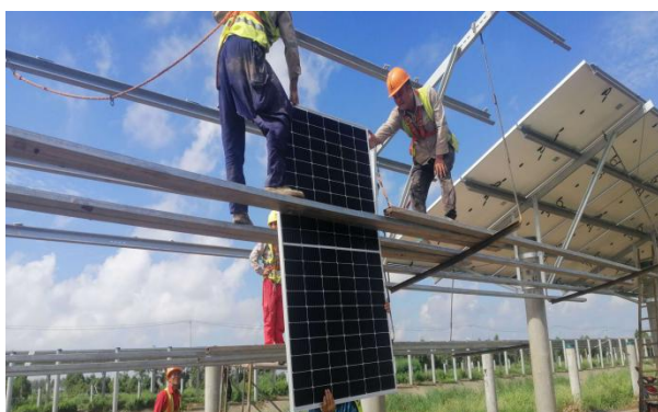
光伏组件安装
