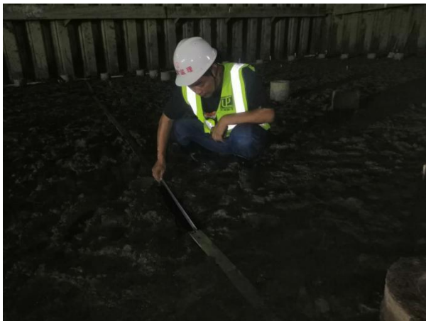
升压站接地扁钢 预埋
