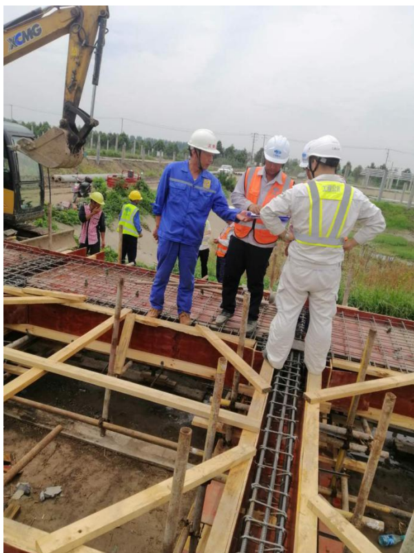
箱变基础钢筋模 板验收
