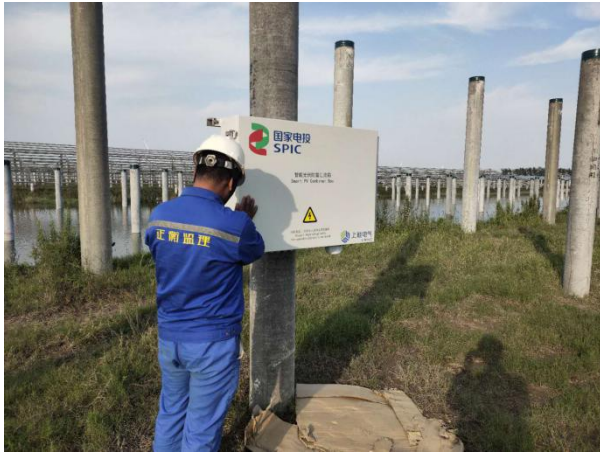
光伏区汇流箱安 装
