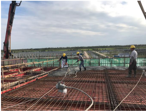
升压站二层顶板 浇筑
