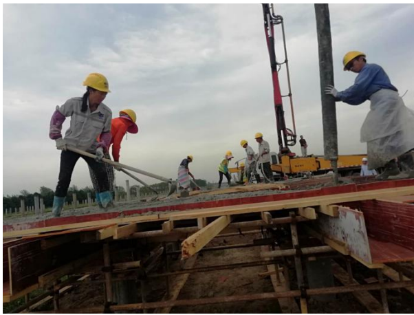
箱变基础浇筑
