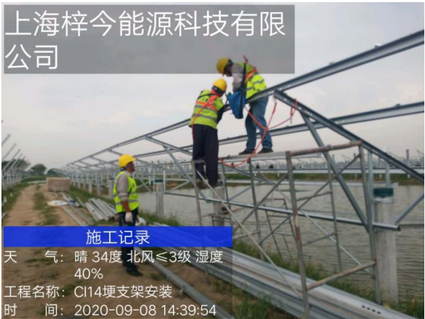
光伏区支架安装
