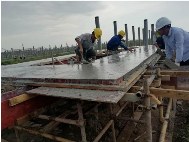
箱变基础浇筑收面
