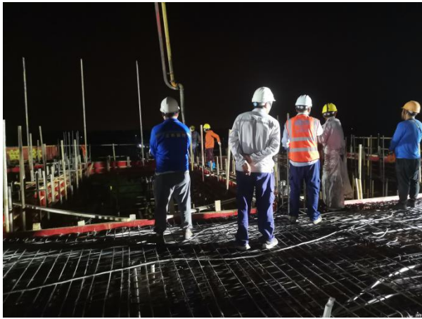
升压站一层梁柱 二层底板浇筑
