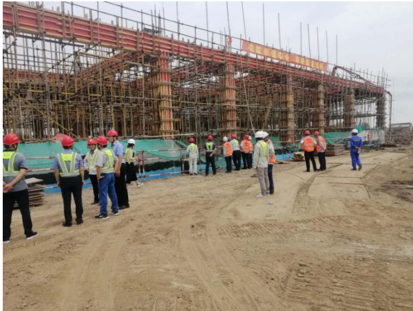
光伏区脚手架搭 设检查
