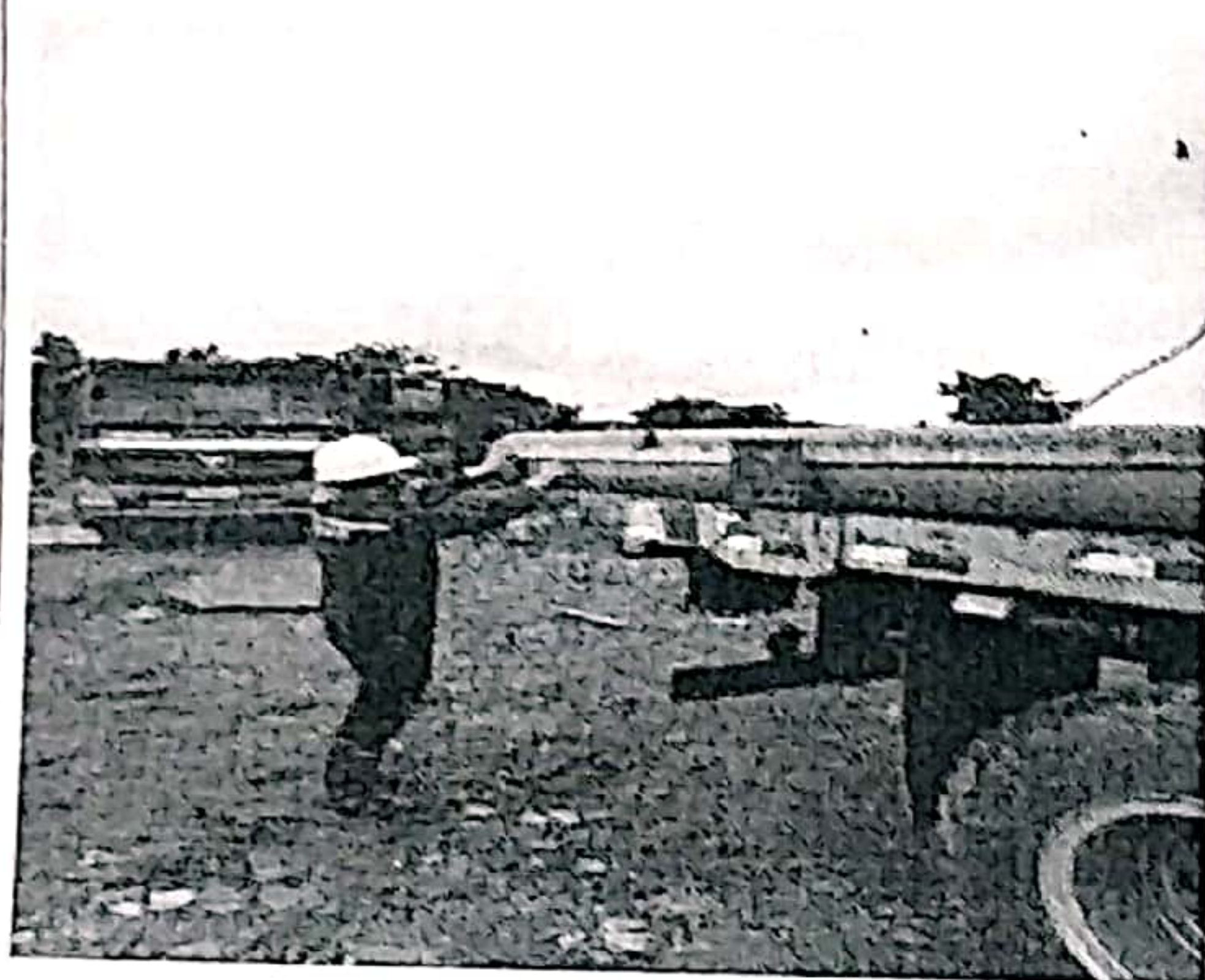
对进场管桩进行检查
