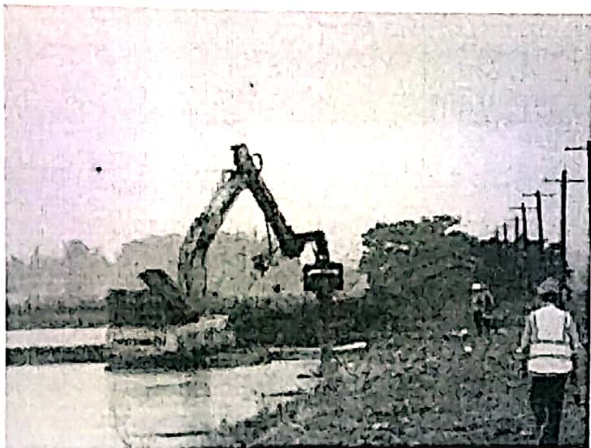
试打第一根管桩
