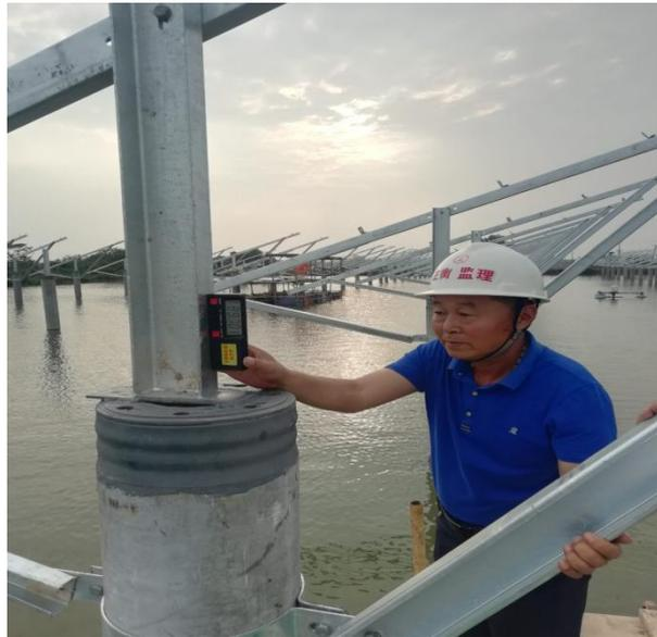
检查立柱焊接垂直度
