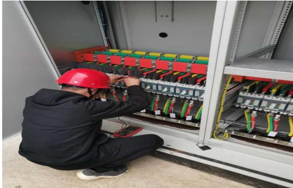
箱变低压端检查、送电
