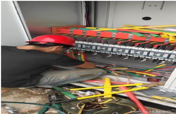
箱变低压侧电缆头制作
