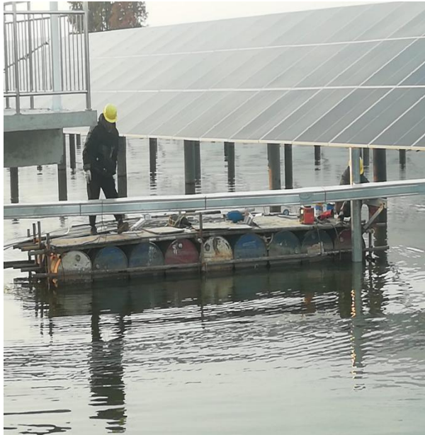
接地扁铁焊接
