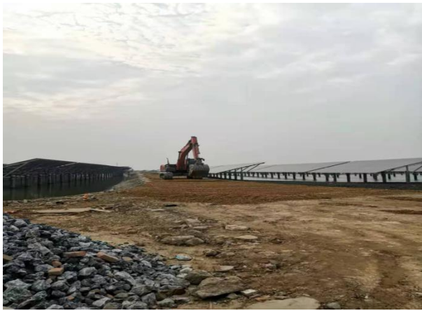
道路面层铺筑
