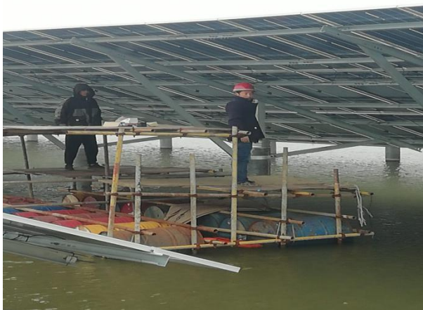
组件接地小黄线施工
