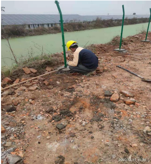
围栏基础浇筑
