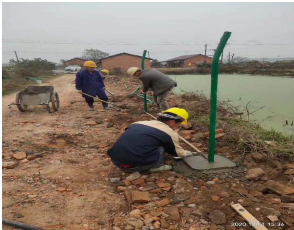
围栏基础浇筑 01
