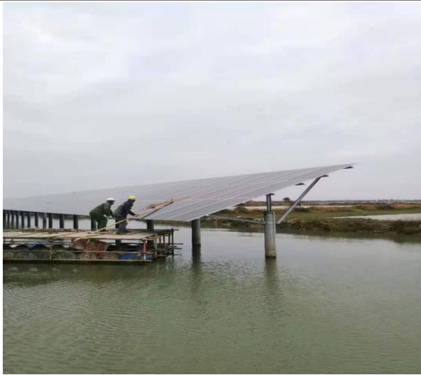
组件排查、维修
