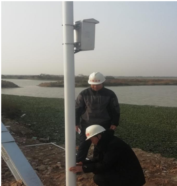
场区监控设备检查验收
