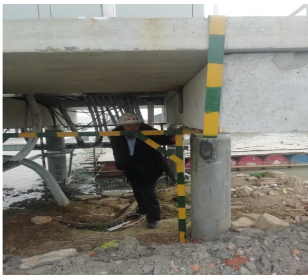
检查验收接地焊接质量
