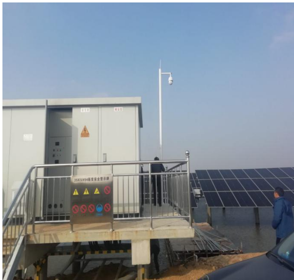
场区监控检查验收
