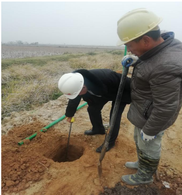
监理人员巡视检查围栏施工
