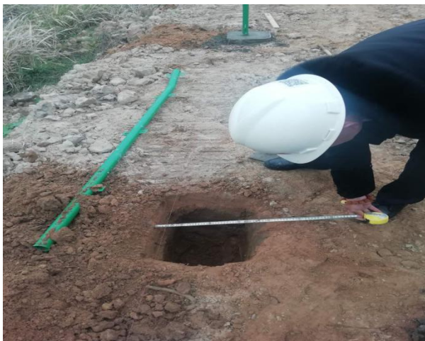
监理人员巡视检查围栏施工 01
