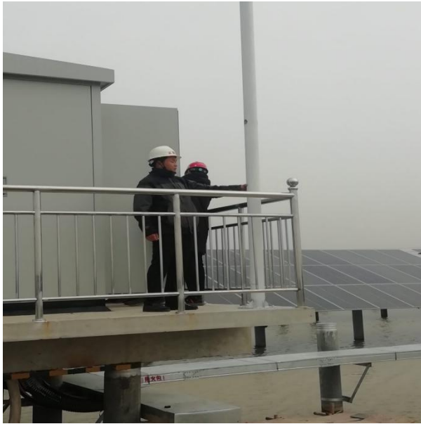
检查验收箱变安装质量
