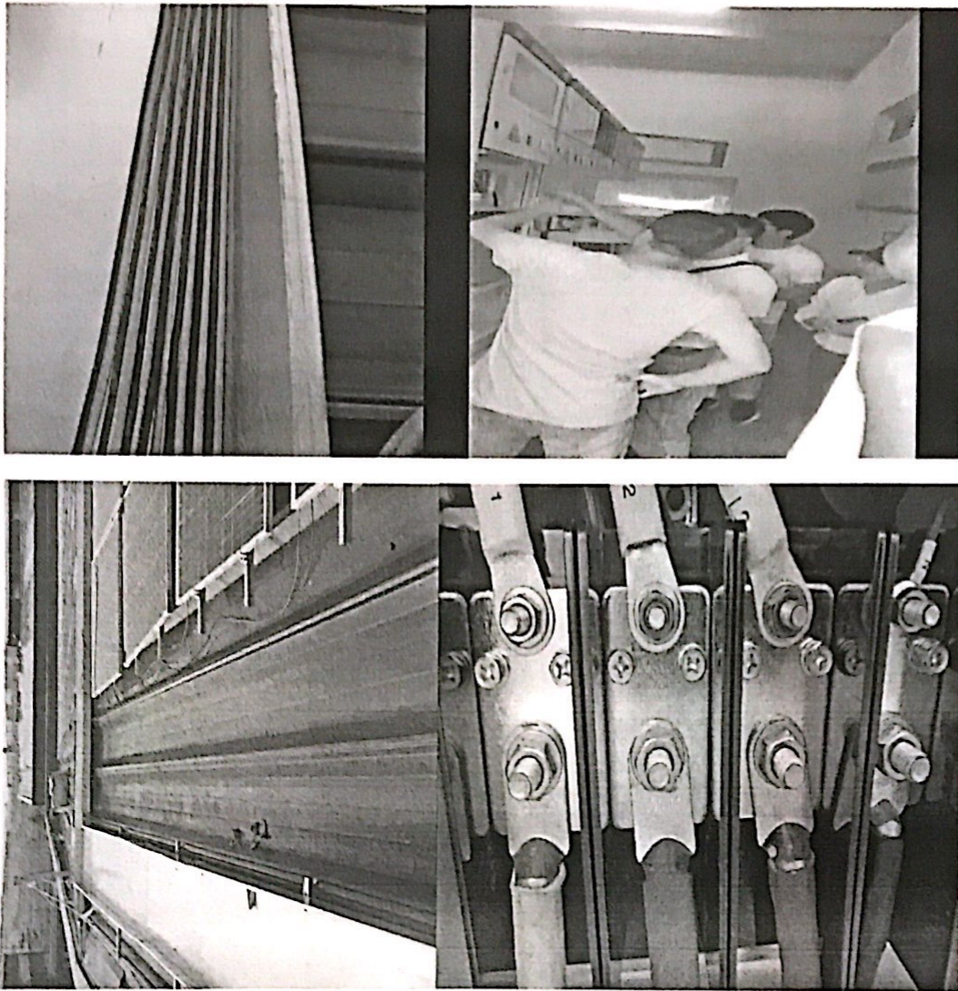
组件安装、桥架安装、电缆敷设接线、供电局验收
