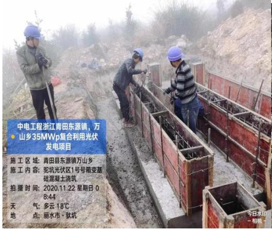
中电工程浙江青田东源镇、万山乡35MWp复合利用光伏发电项目
