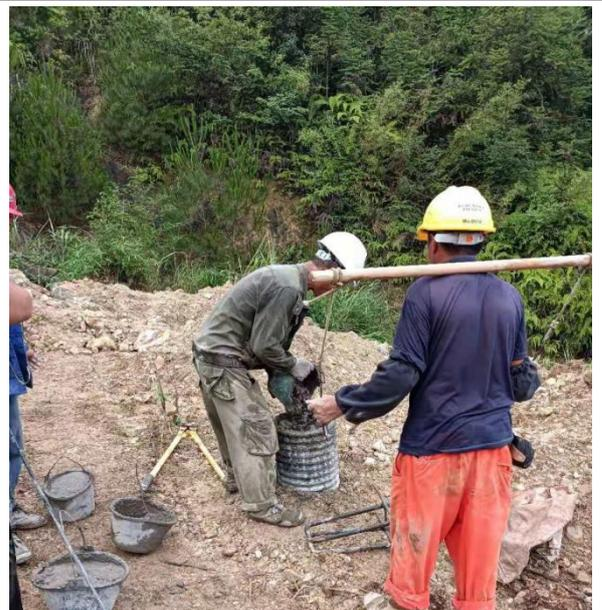
龙须区 S4 区域桩基浇筑混凝土
