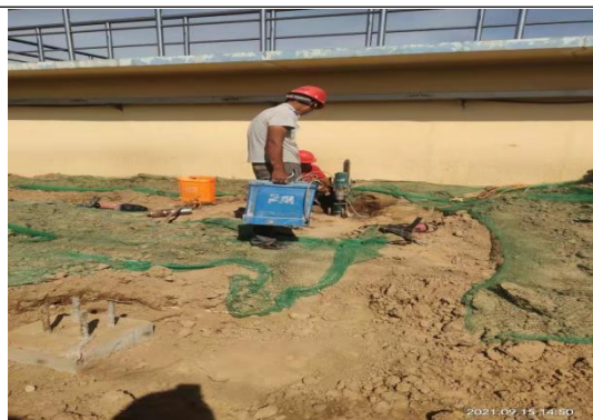
基础开抗剪件孔
