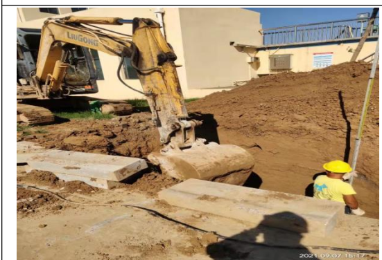
A 区基槽开挖
