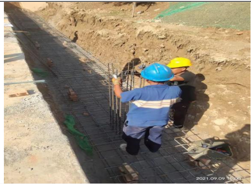
基础钢筋绑扎
