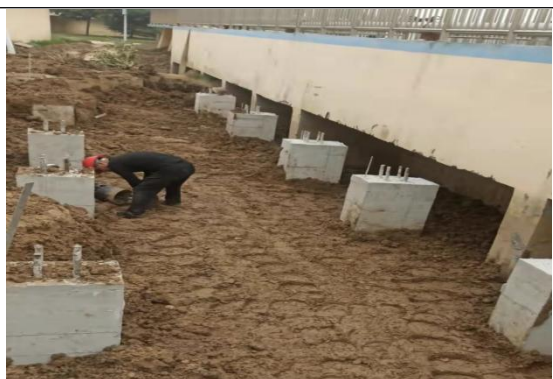
基础夯实回填
