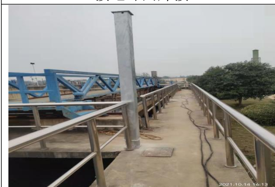
中间钢结构立柱安装
