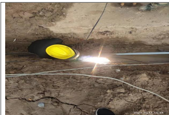
接地环网焊接
