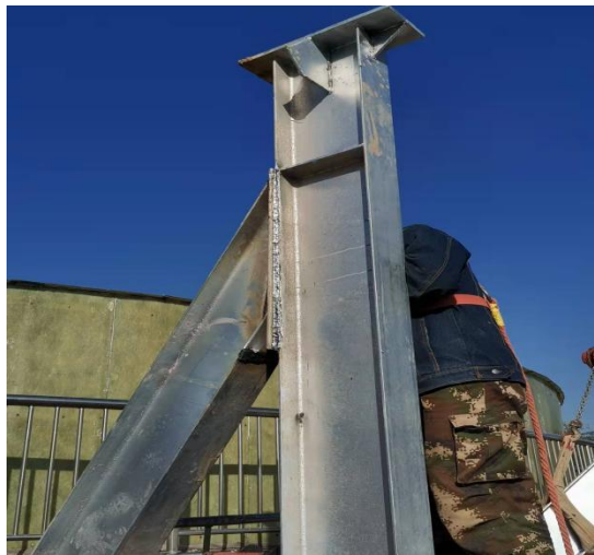
钢结构立柱焊接
