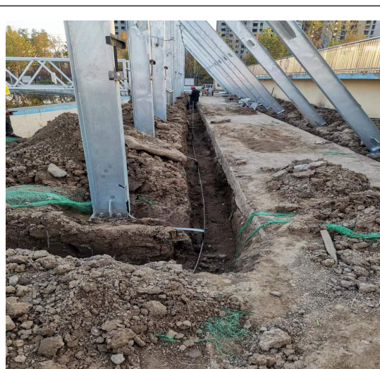
接地环网施工检查
