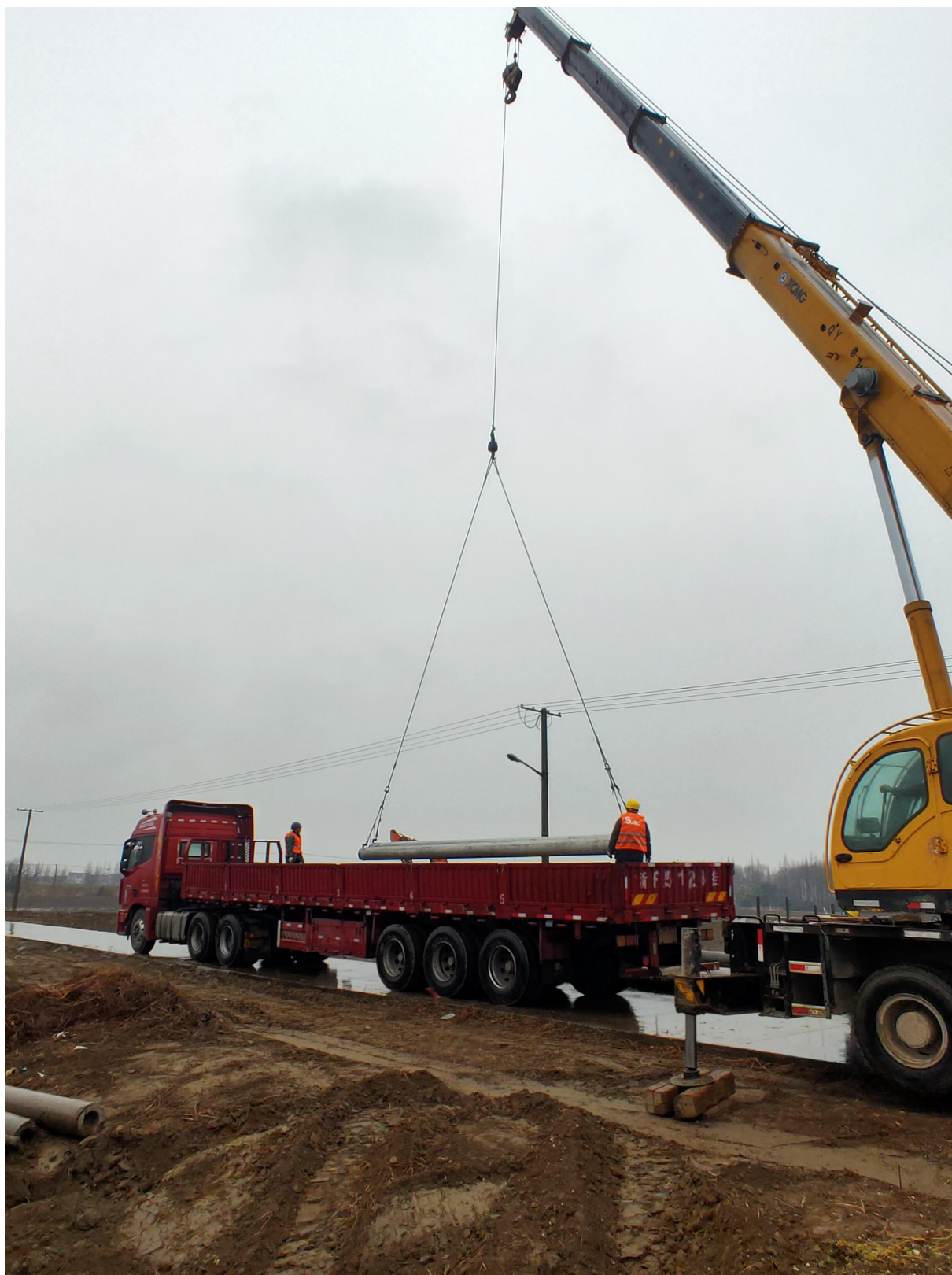
管桩卸车安全旁站
