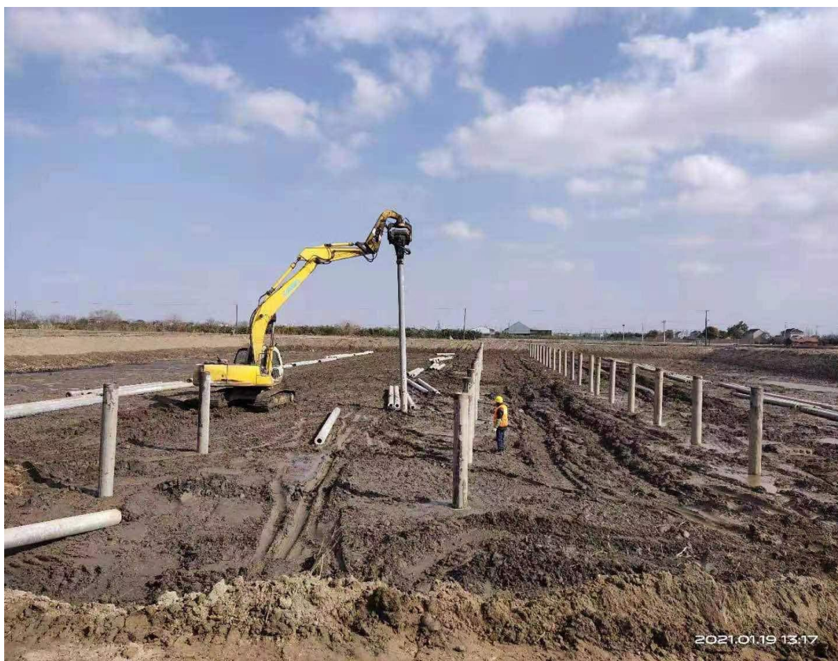
旁站光伏区桩基施工
