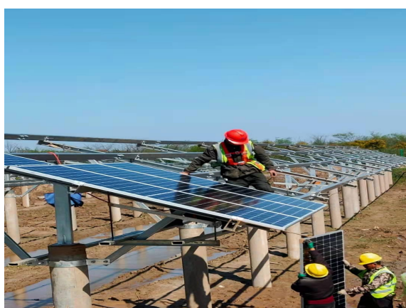
光伏区组件安装
