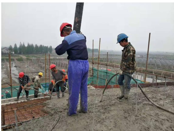
开关站混凝土浇筑
