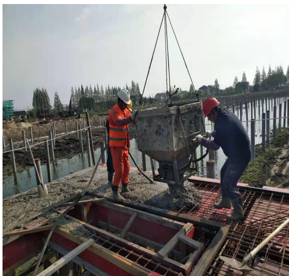
箱变基础浇筑
