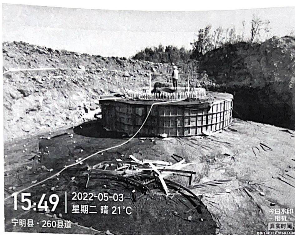
17#风机基础养护
