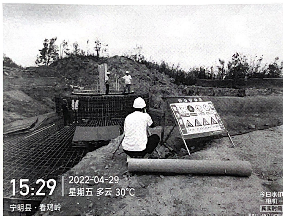
17#风机基础钢筋验收
