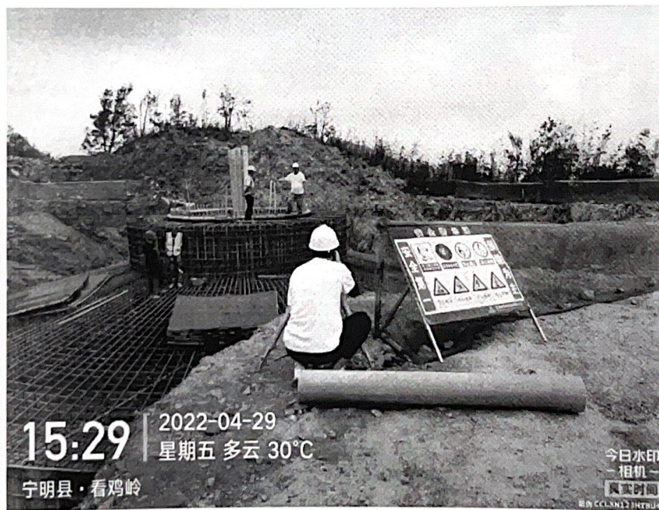
17#风机基础钢筋验收
