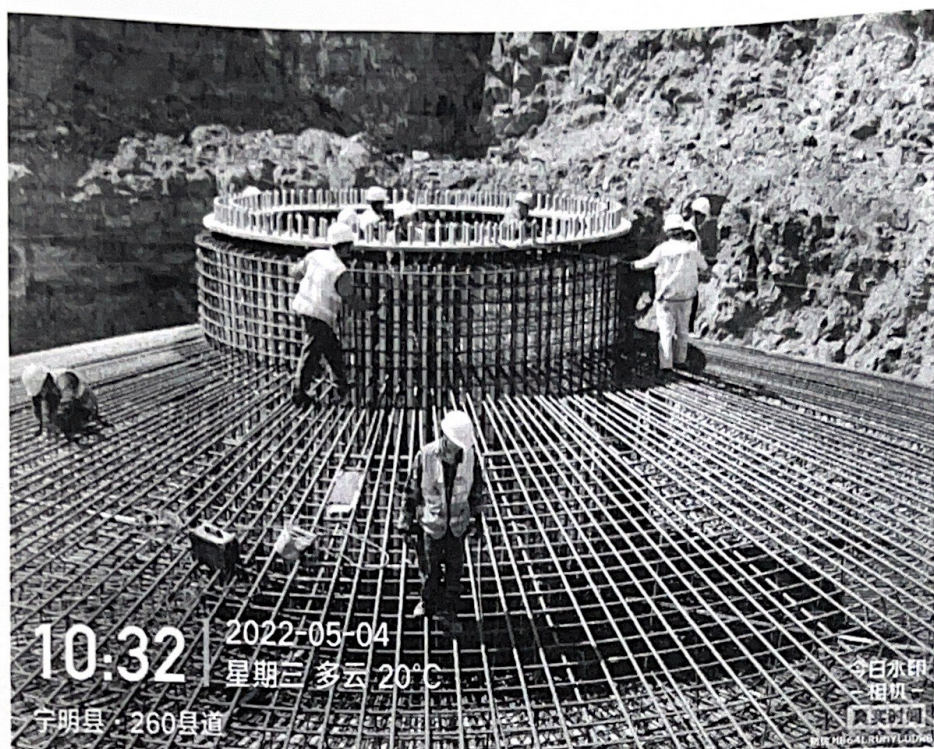
18#风机基础钢筋绑扎
