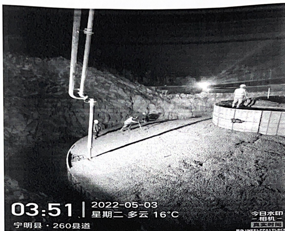
17#风机基础浇筑
