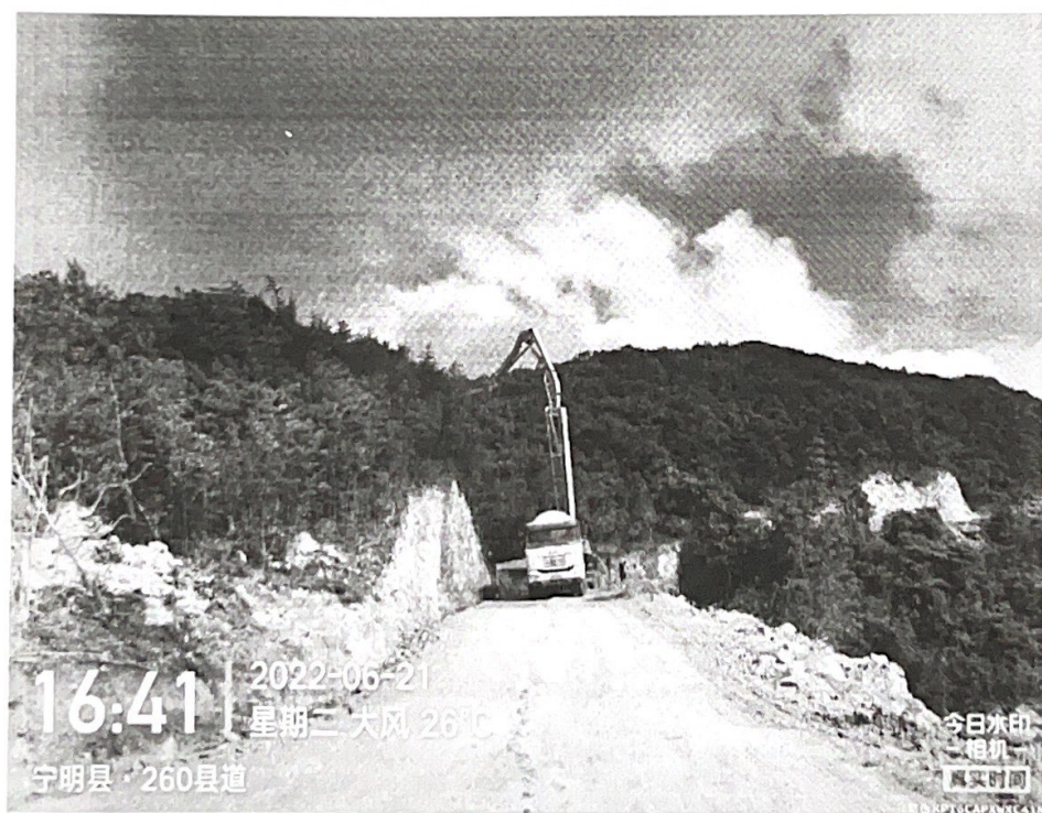
集电线路线塔基础浇筑
