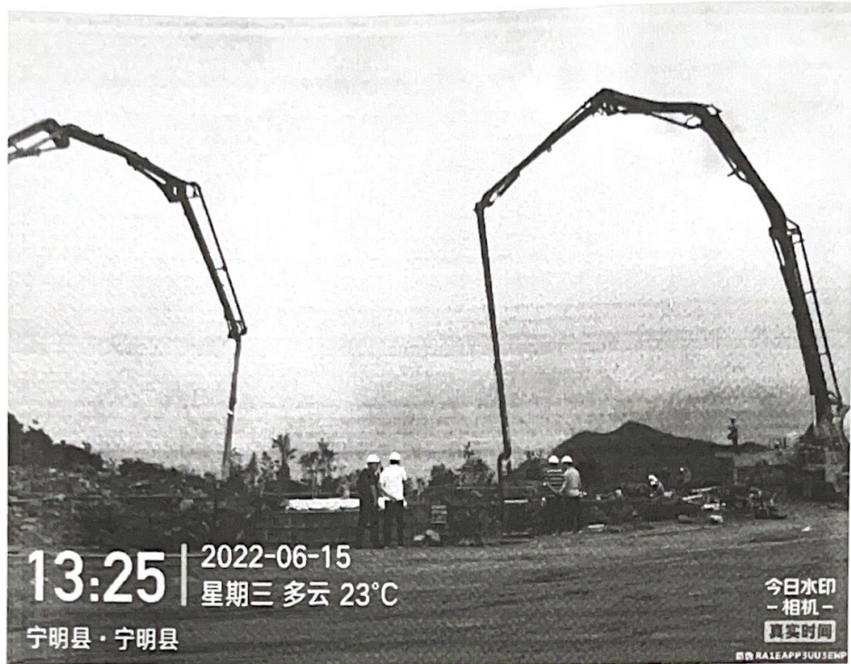
19#风机基础浇筑
