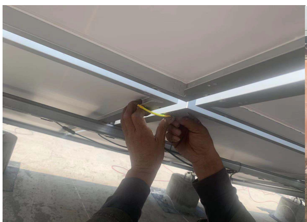
接地黄绿线安装
