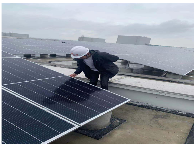
组件安装检查
