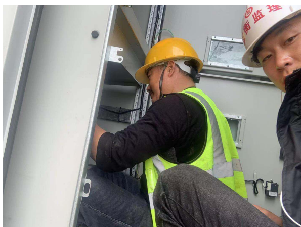
高压电缆头制作旁站
