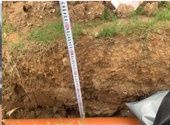
电缆沟深度测量
