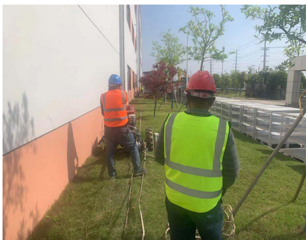
高压电缆敷设
