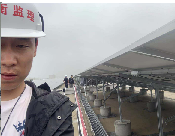
交流电缆敷设检查
