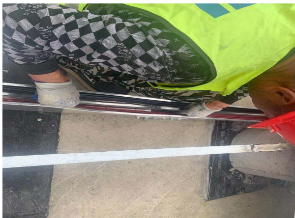
桥架隔板安装
