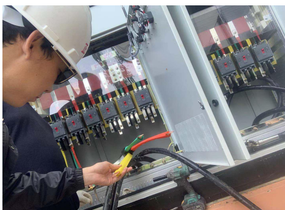
低压电缆头制作旁站
