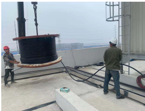
交流电缆敷设
