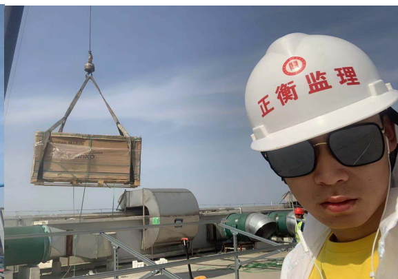
组件吊装安全旁站
