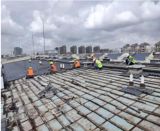
公寓楼瓦片拆除
