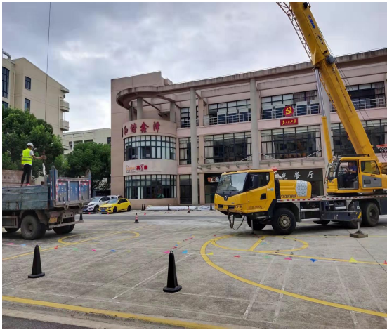
废水泥墩吊运
