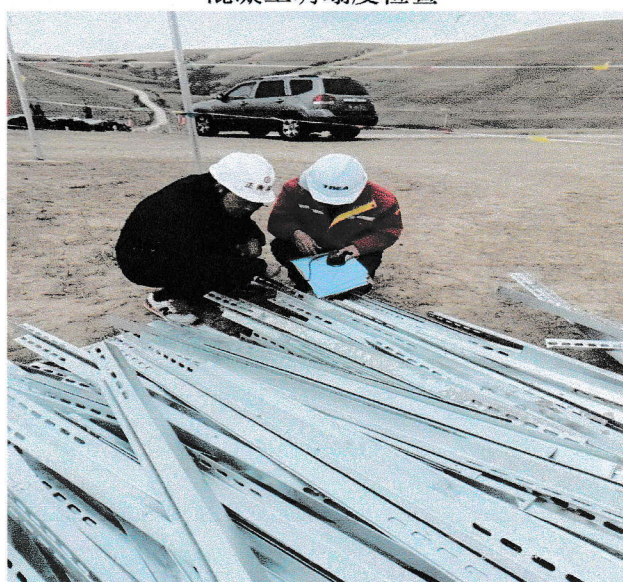
材料进场检查（支架材料）
