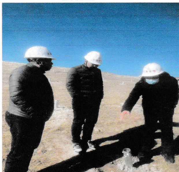
光伏区预埋件检查
