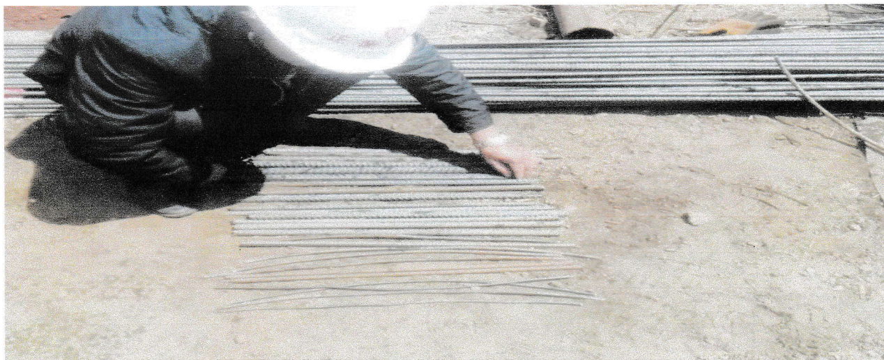
钢筋见证取样
