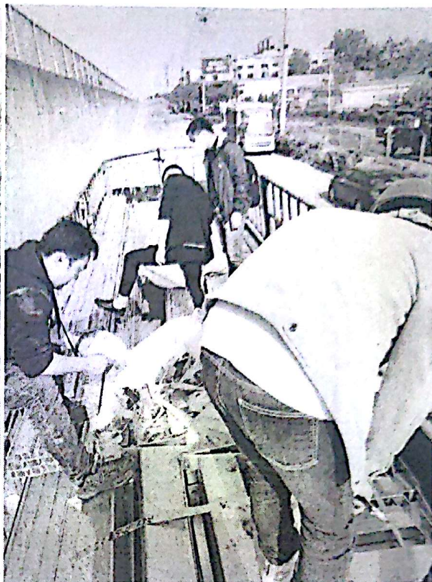
支架到场检查
