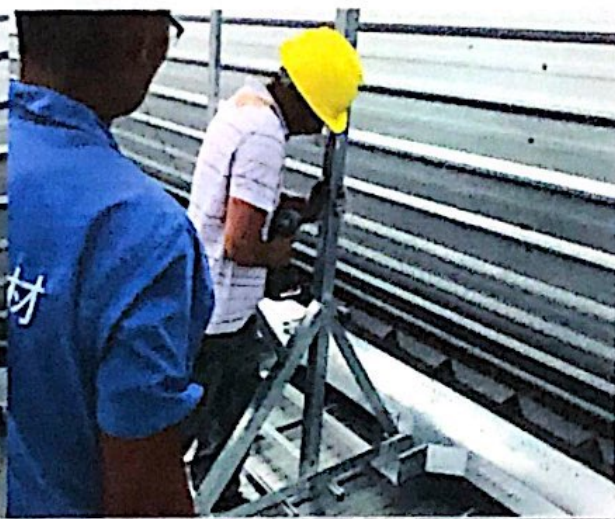
逆变器支架安装
