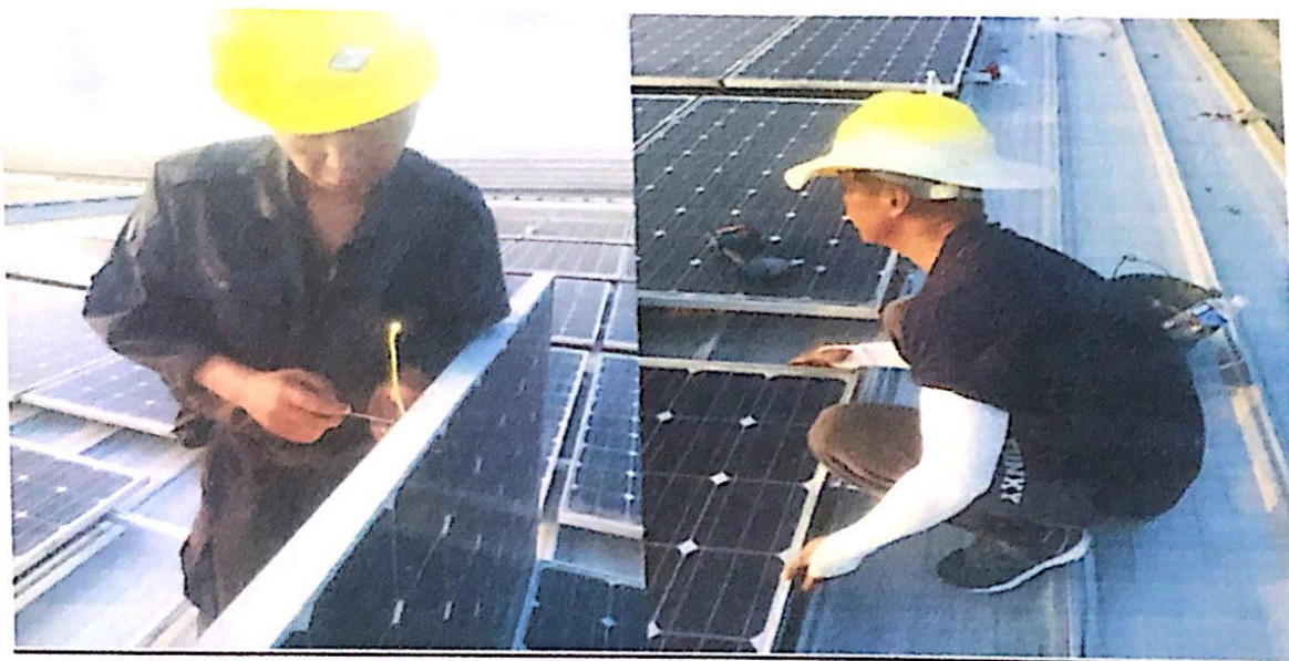
接地小黄线安装
