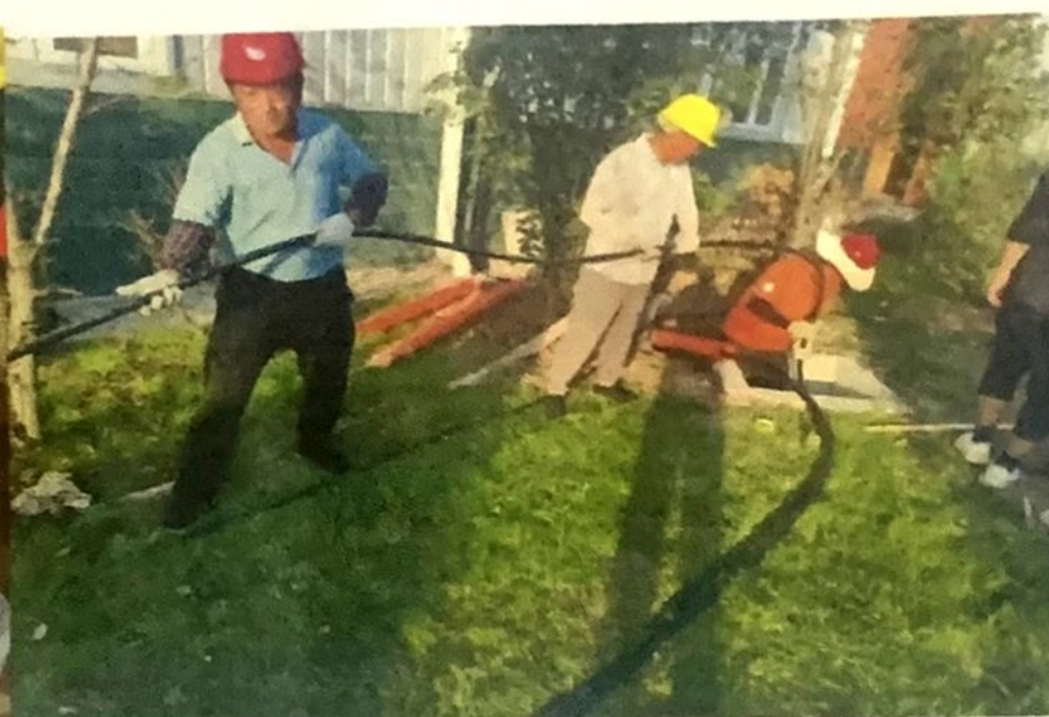
交流电缆敷设
