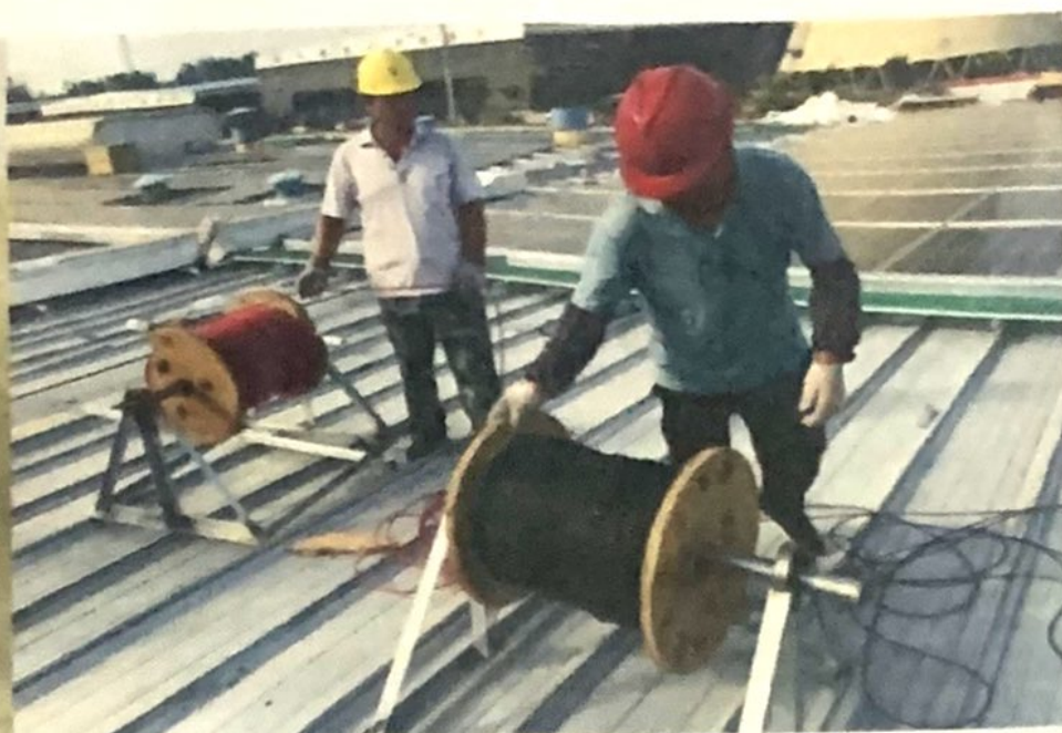
直流电缆敷设
