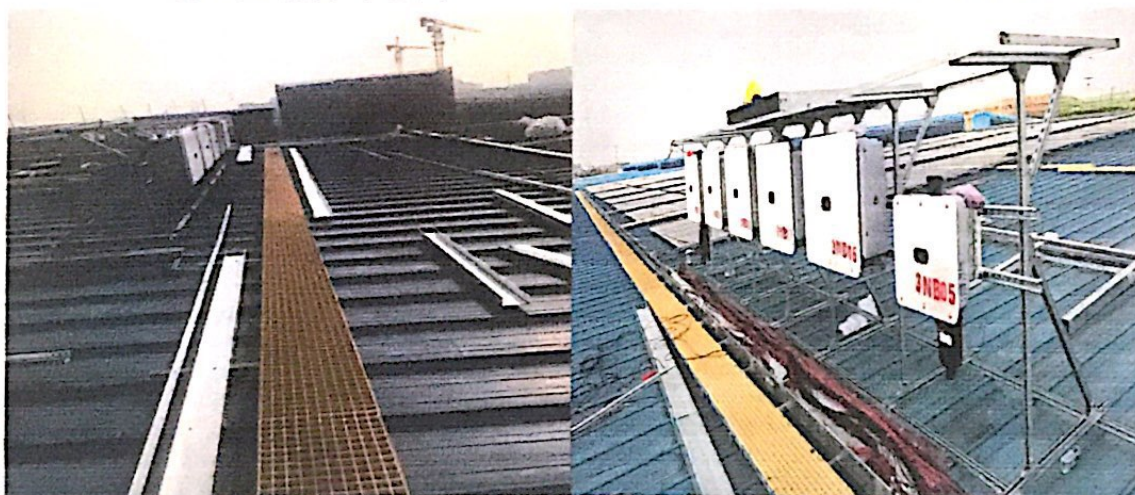
检修通道安装
