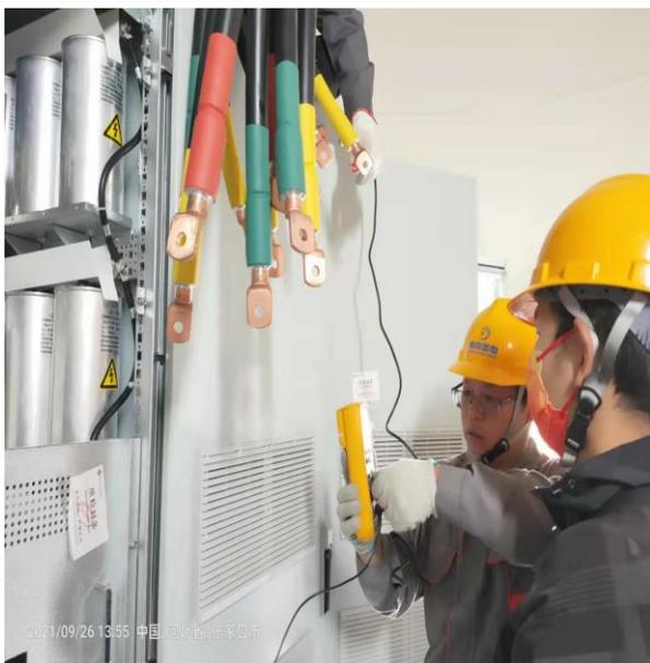
低压电缆绝缘测试
