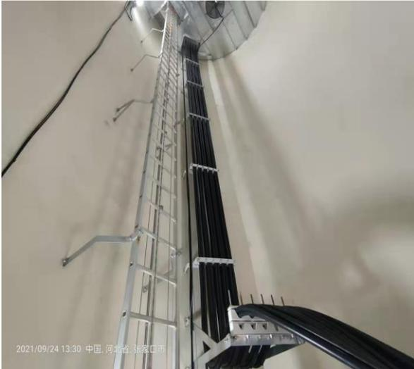
塔筒内低压电缆敷设完成
