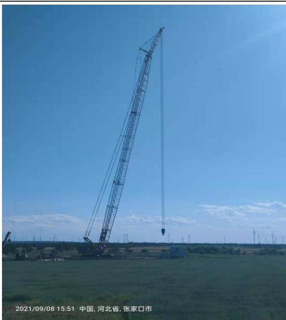
550 吨履带吊组装完成
