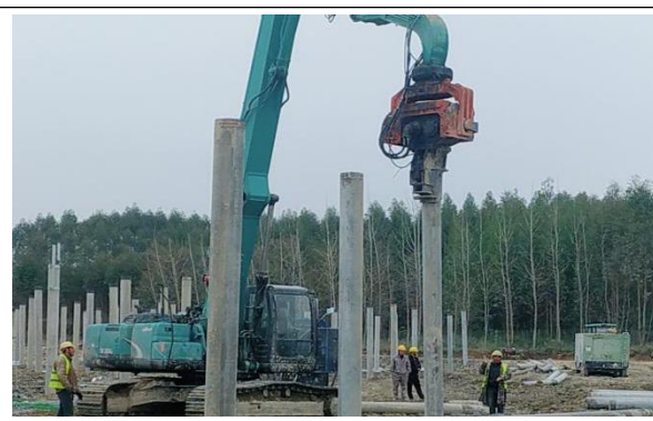
光伏区桩基打桩
