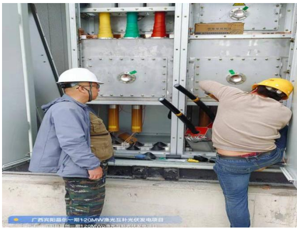
升压站进线柜高压电缆头制作
