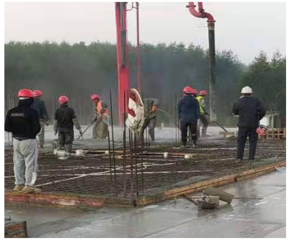
升压站一层顶浇筑混凝土
