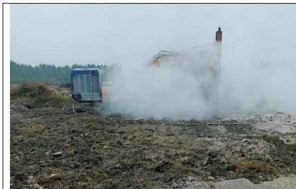
光伏区桩基引孔
