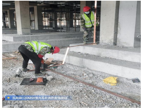
升压站接地环网施工
