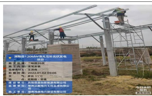
光伏区支架安装
