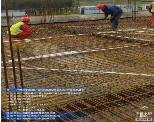
升压站综合楼一层绑扎钢筋
