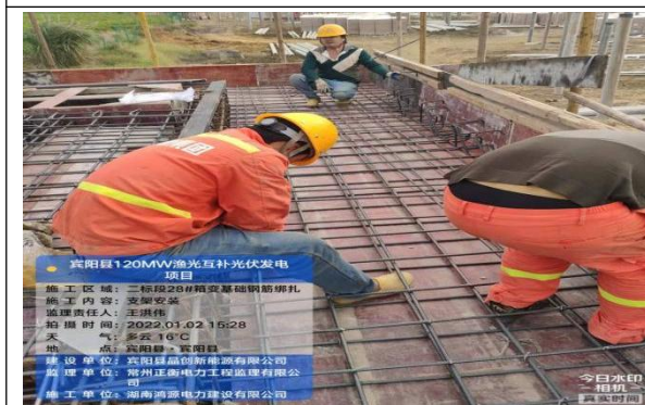
28 区箱变平台绑扎钢筋
