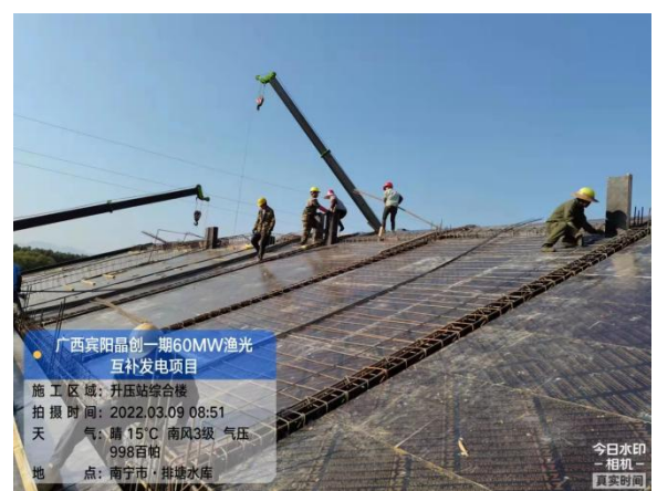
升压站综合楼屋面绑扎钢筋
