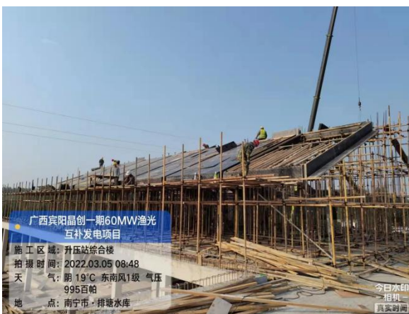
升压站综合楼二层搭设支撑脚手架、模板制作
