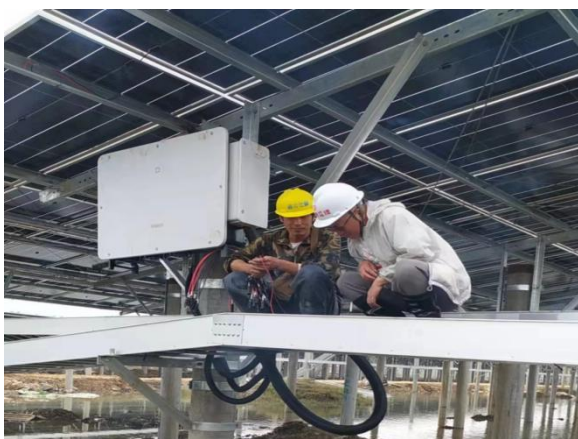
光伏区逆变器直流电缆端接
