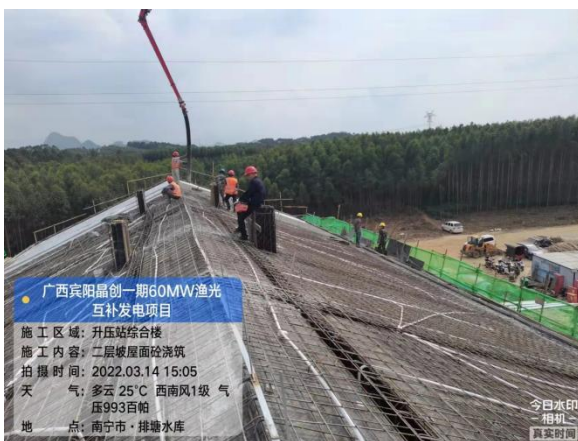
升压站综合楼屋面浇筑混凝土
