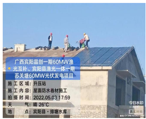
升压站屋面防水卷材施工
