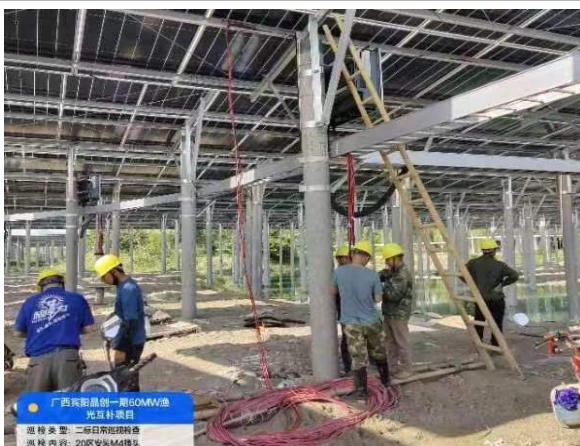
二标段光伏区直流电缆敷设
