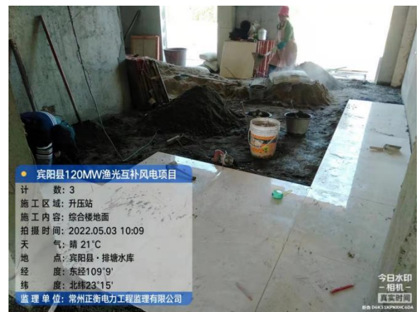
升压站综合楼地面砖施工
