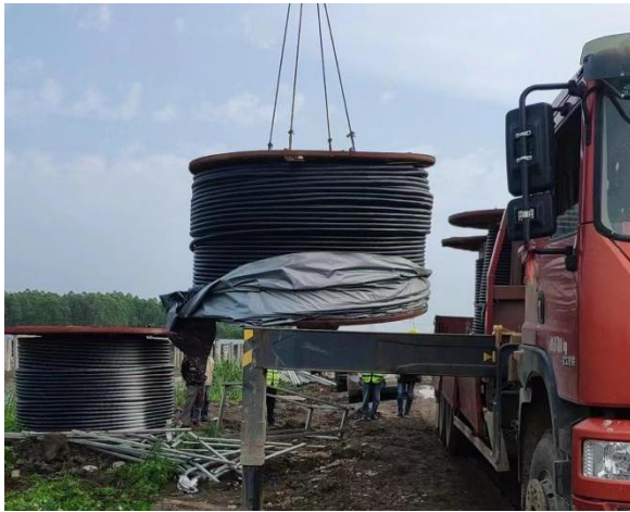
一标段光伏区电缆敷设施工
