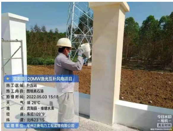
升压站围墙真石漆施工
