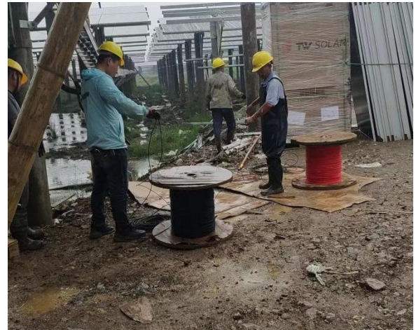
一标段光伏区电缆敷设施工
