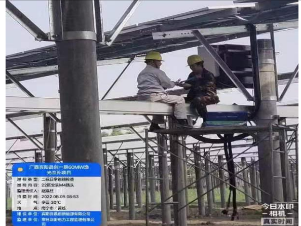
二标段光伏区逆变器电缆端接
