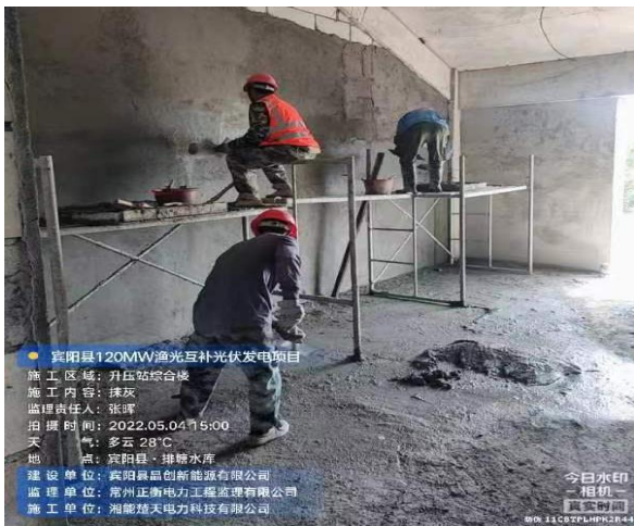
升压站综合楼墙体抹灰
