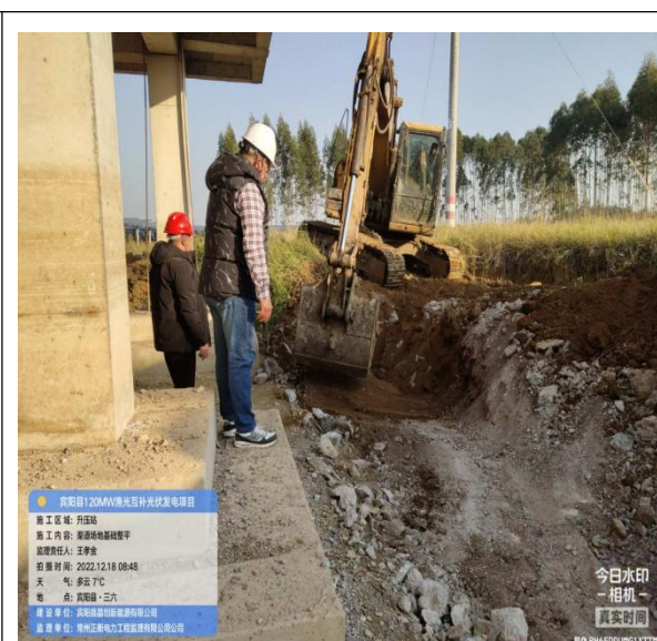
平台基础排水沟施工
