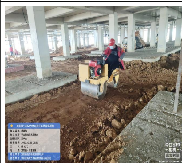
升压站平台基础回填土施工
