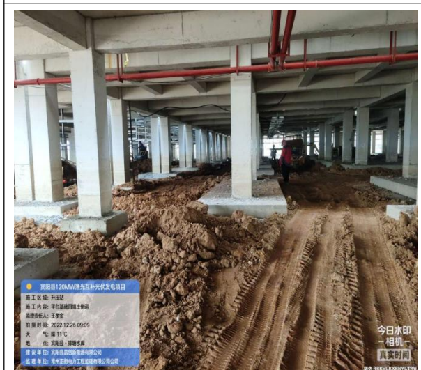
升压站平台基础回填土施工
