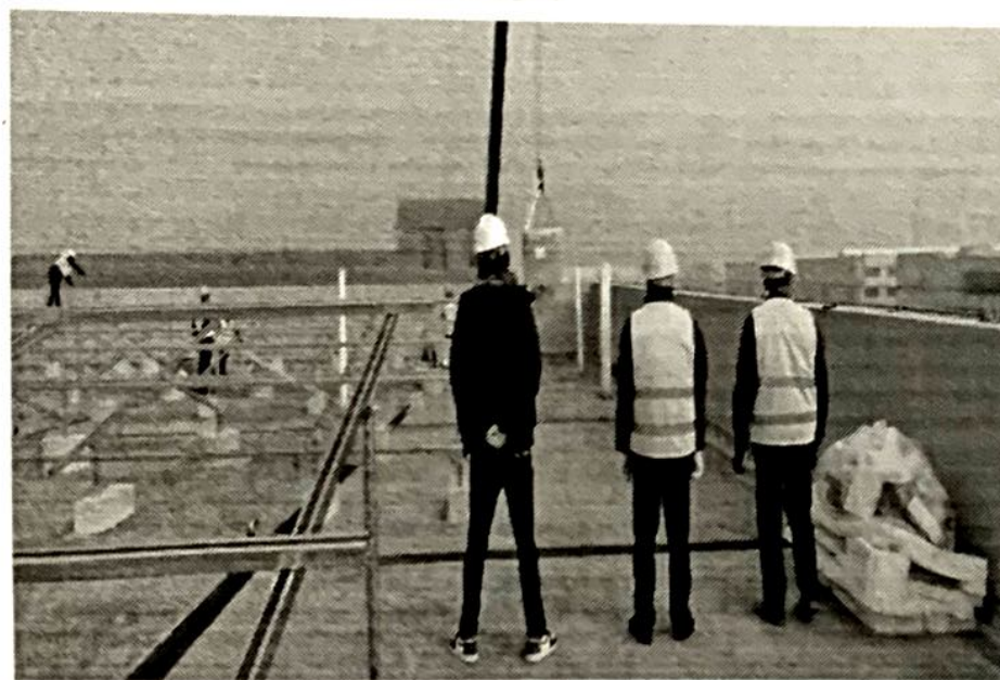
吊装组件旁站
