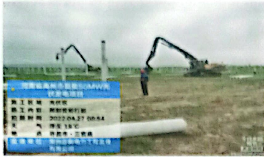
预制管桩打桩检查
