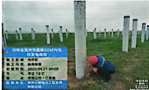
管桩标高检查
