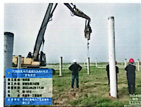
管桩拉拔力实验
