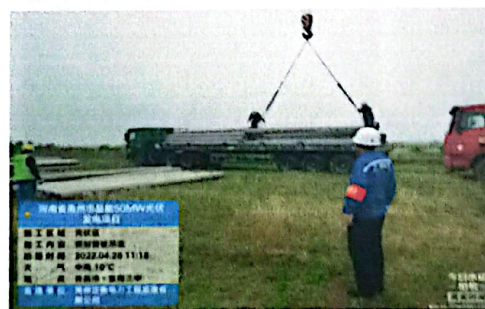
预制管桩吊装
