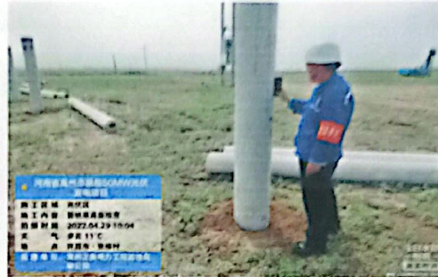
管桩垂直度检查
