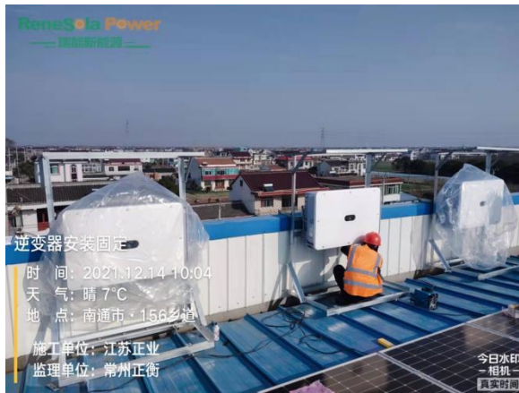
光伏逆变器安装固定
