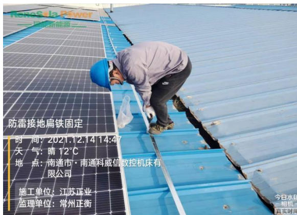
防雷接地扁铁固定
