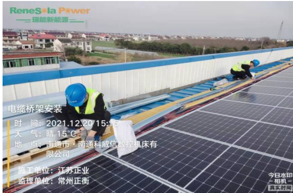
电缆桥架安装固定
