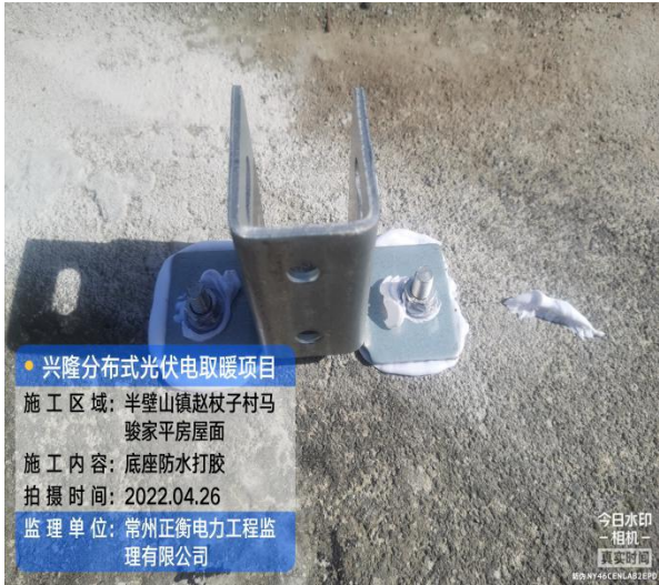
平房屋顶光伏支架安装完成
