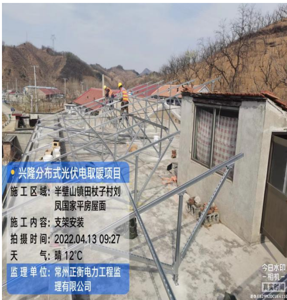
平房屋顶光伏支架安装完成
