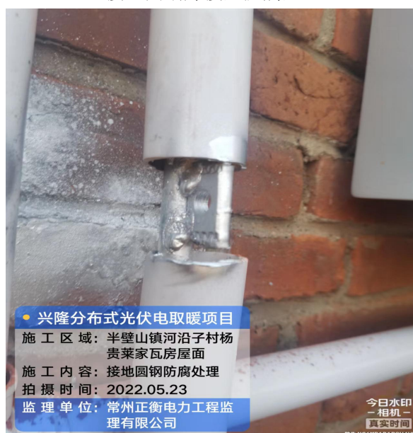
接地圆钢焊接处防腐处理
