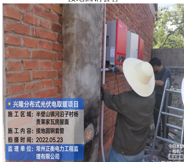
接地圆钢焊接处防腐处理
