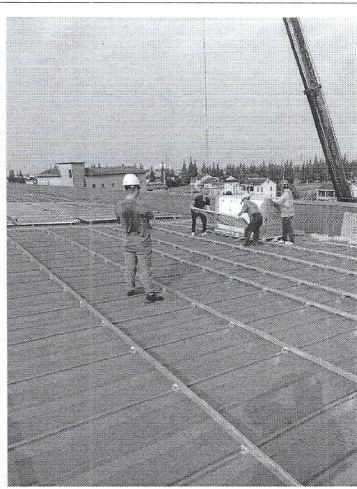
组件搬运旁站
