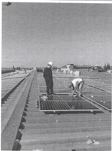
组件安装检查
