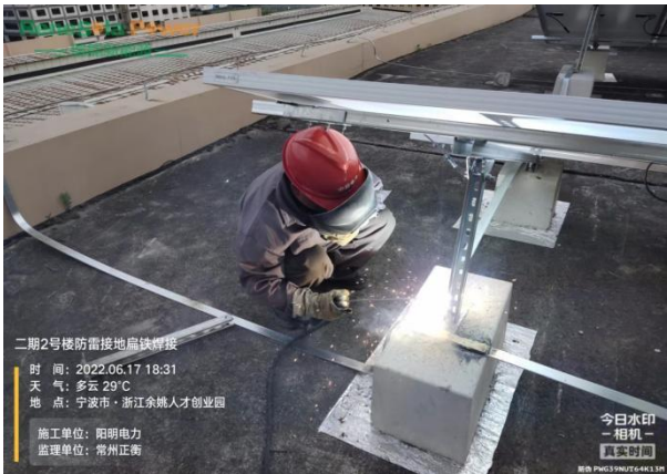
防雷接地扁铁焊接
