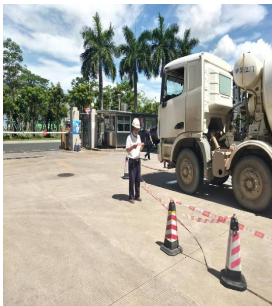
进场混凝土检查
