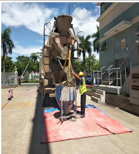
混凝土材料吊运
