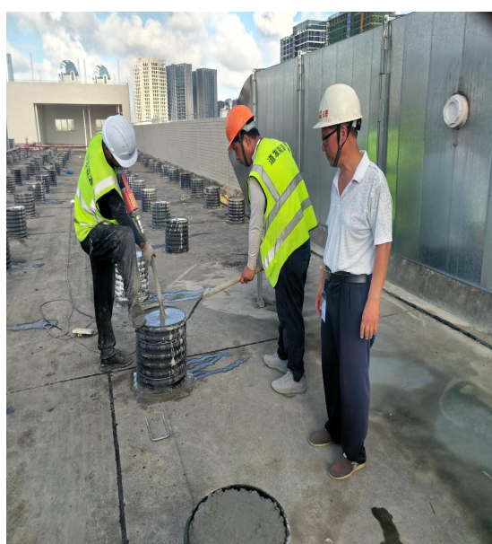
混凝土基座浇筑旁站
