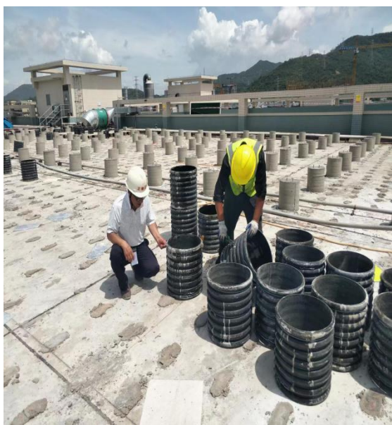
基座模具加固检查
