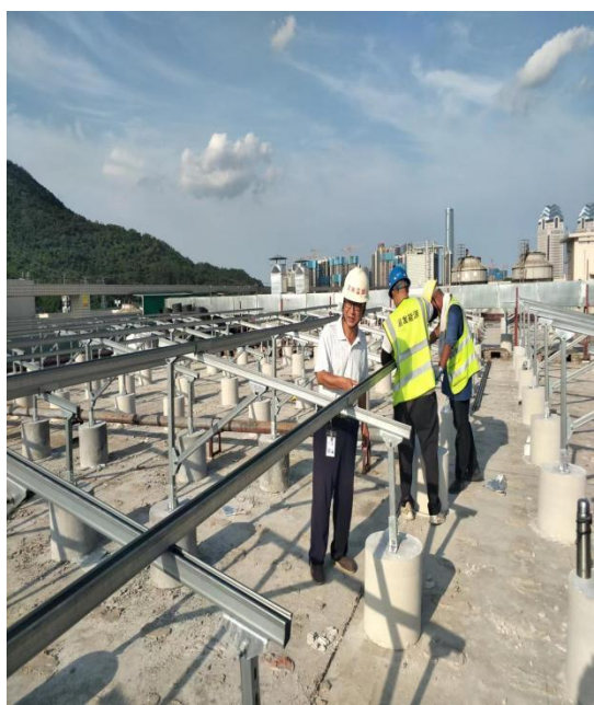
支架安装检查
