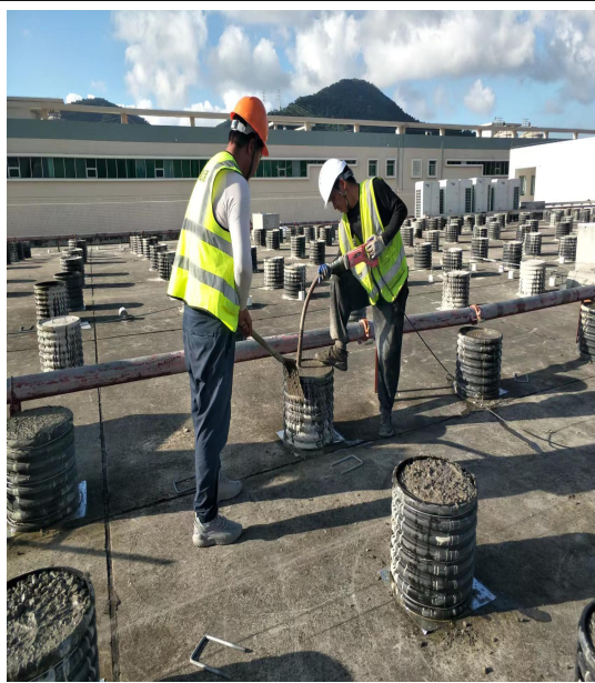
混凝土基座浇筑
