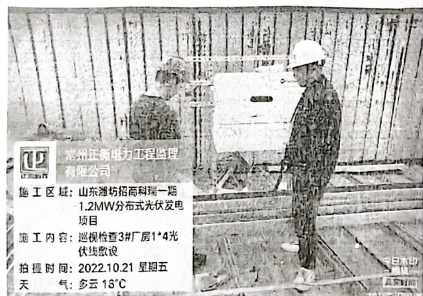
直流电缆敷设
