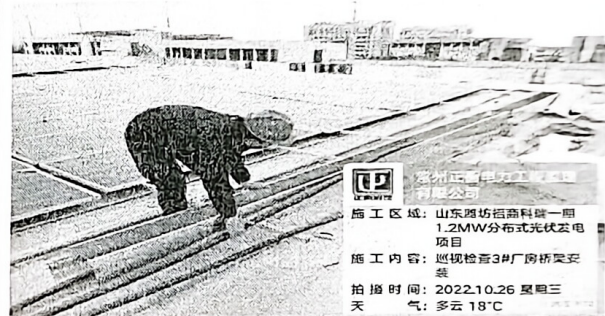
电缆桥架安装
