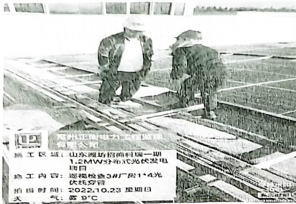
直流电缆穿管
