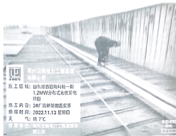
3#厂房电缆桥架盖板安装
