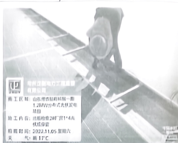
2#厂房直流电缆穿管
