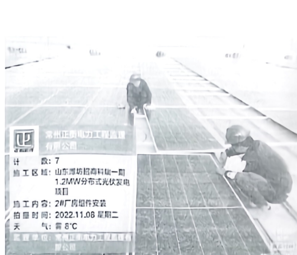
2#厂房组件安装
