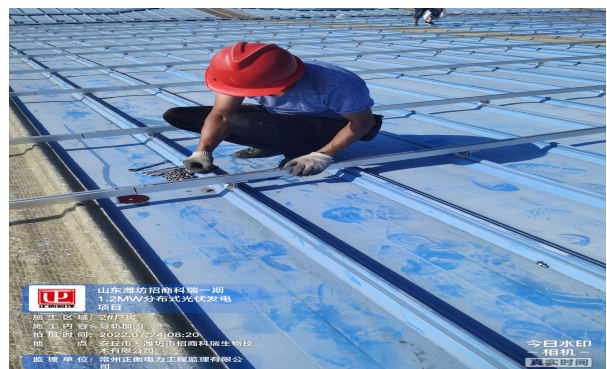
屋面导轨夹具加固
