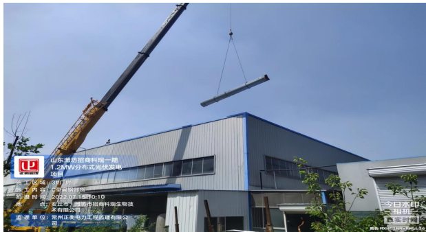
接地扁铁吊装
