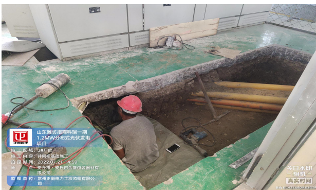
电缆沟施工
