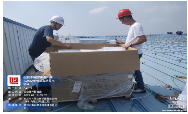
逆变器开箱检查
