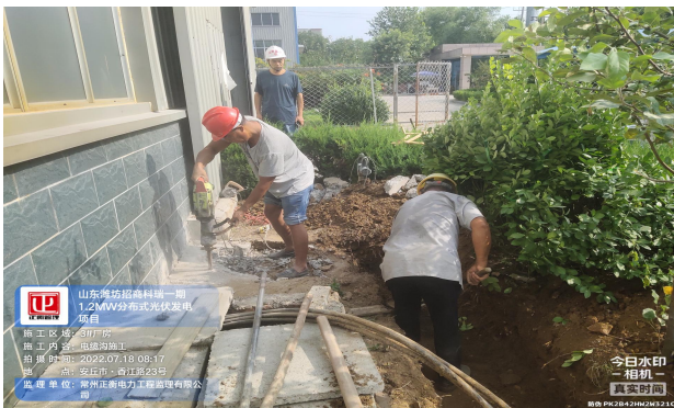
电缆沟施工
