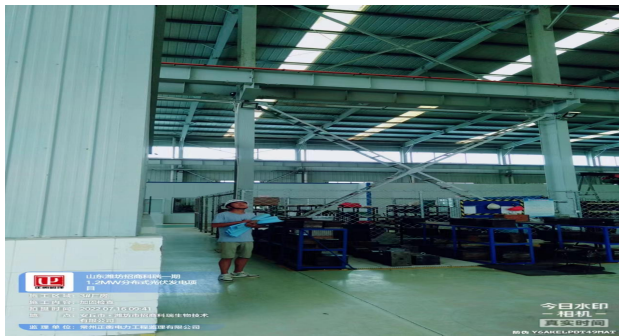
檩条加固检查
