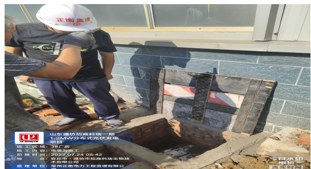
电缆沟防水施工
