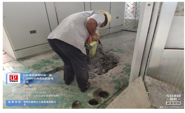
并网柜基础施工
