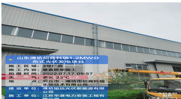
垂直桥架安装
