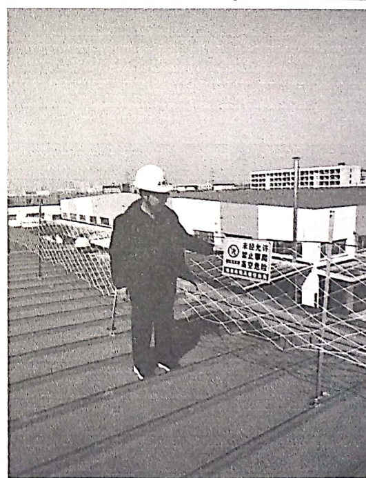
现场安全检查
