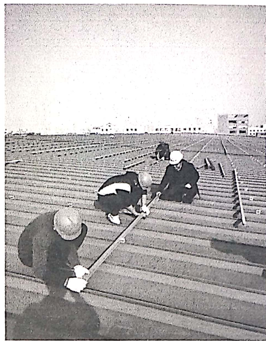
支架安装检查
