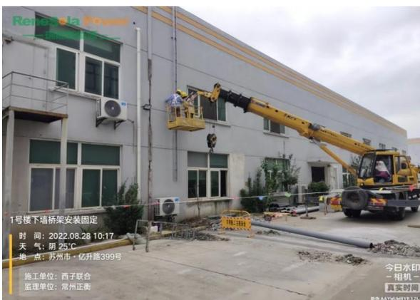
1号楼下墙桥架安装固定
