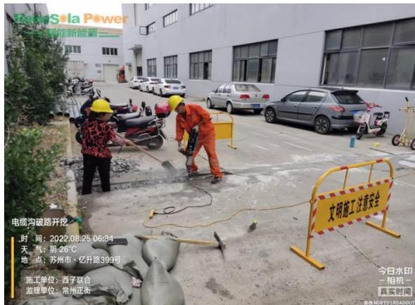
电缆沟破路开挖
