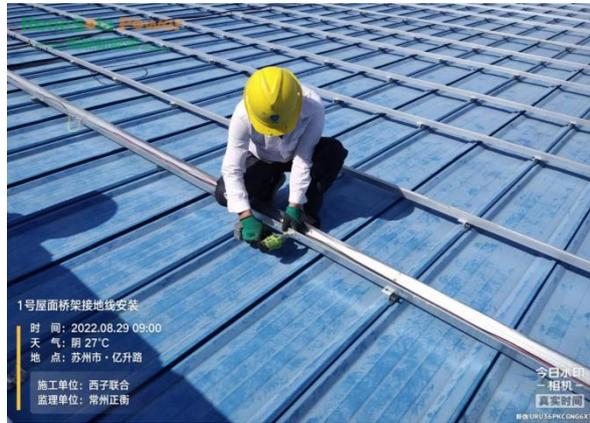
电缆桥架接地线连接固定
