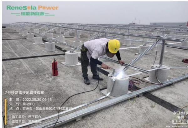
防雷接地扁铁焊接
