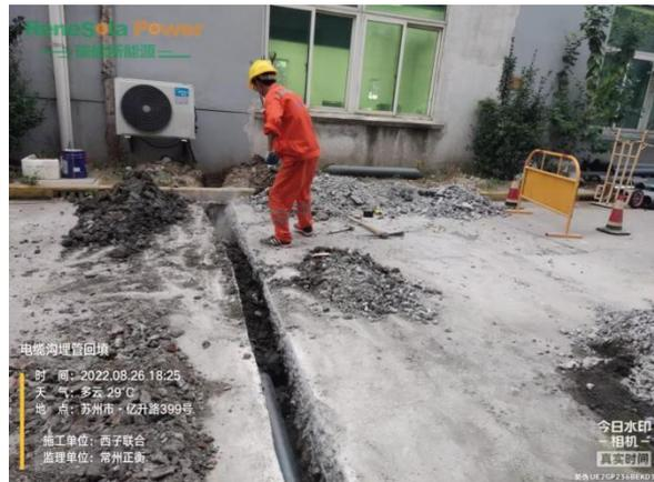
电缆沟埋管回填
