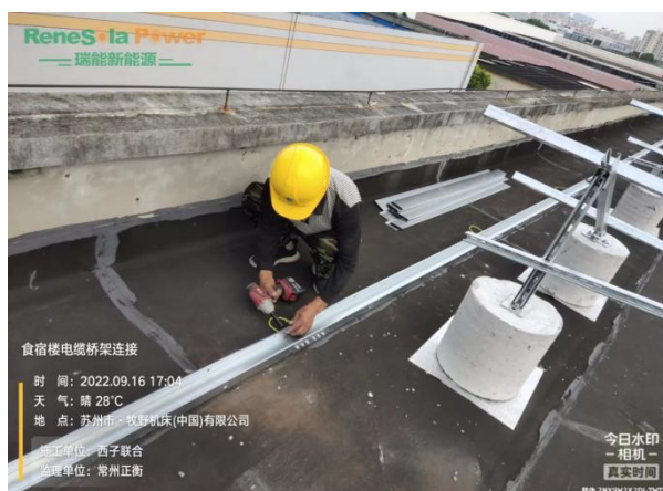
电缆桥架连接固定
