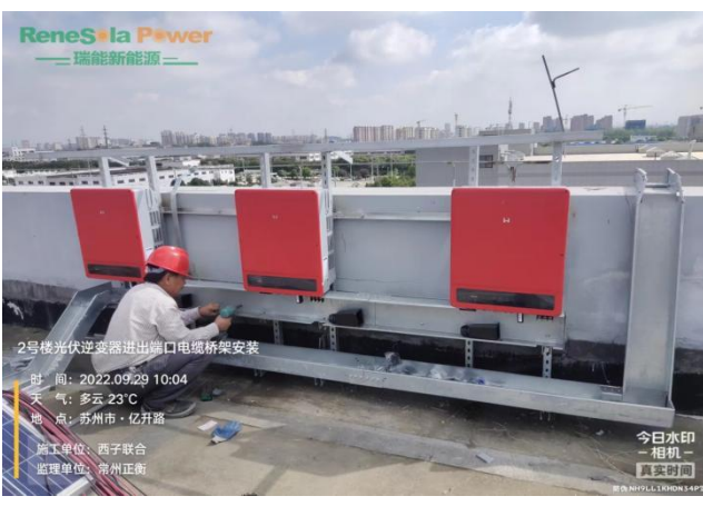
光伏逆变器进出口电缆桥架安装
