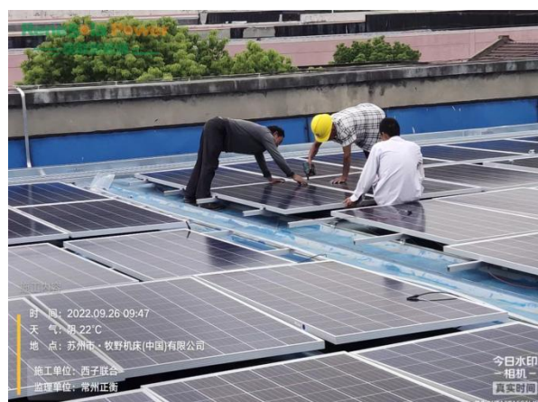
组件安装按压组件
