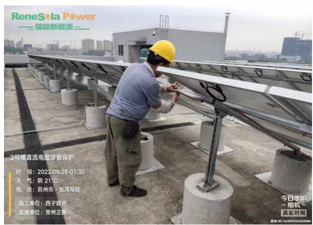
直流电缆穿管保护
