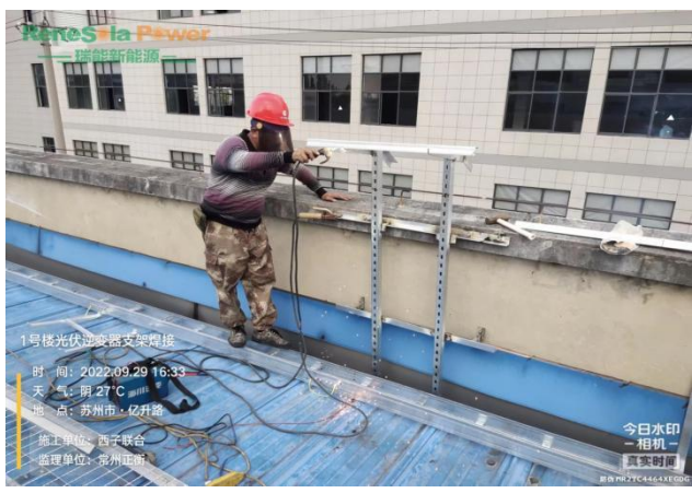
光伏逆变器支架焊接固定
